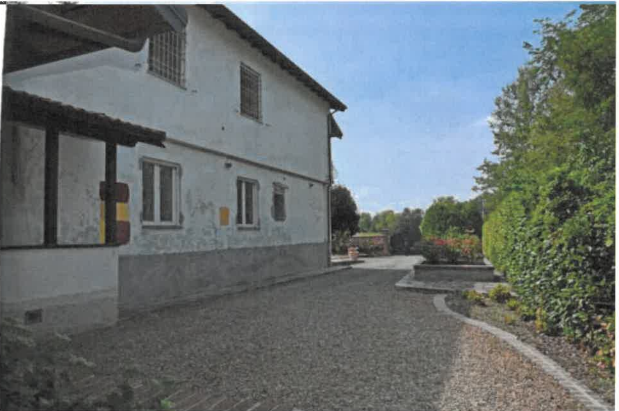
Esterni, fabbricato principale
