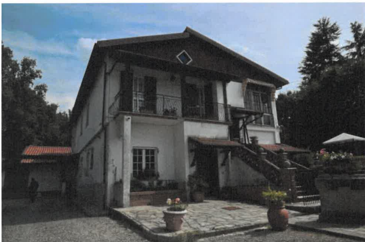
Esterni, fabbricato principale
