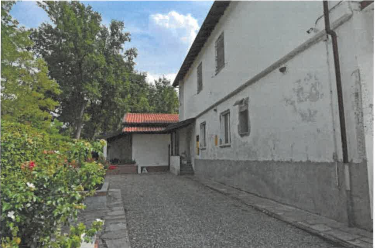
Esterni, fabbricato principale
