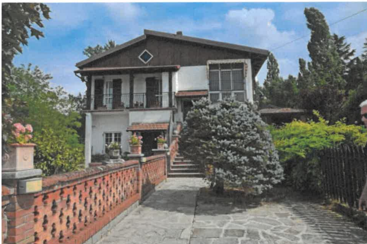
Esterni, fabbricato principale
