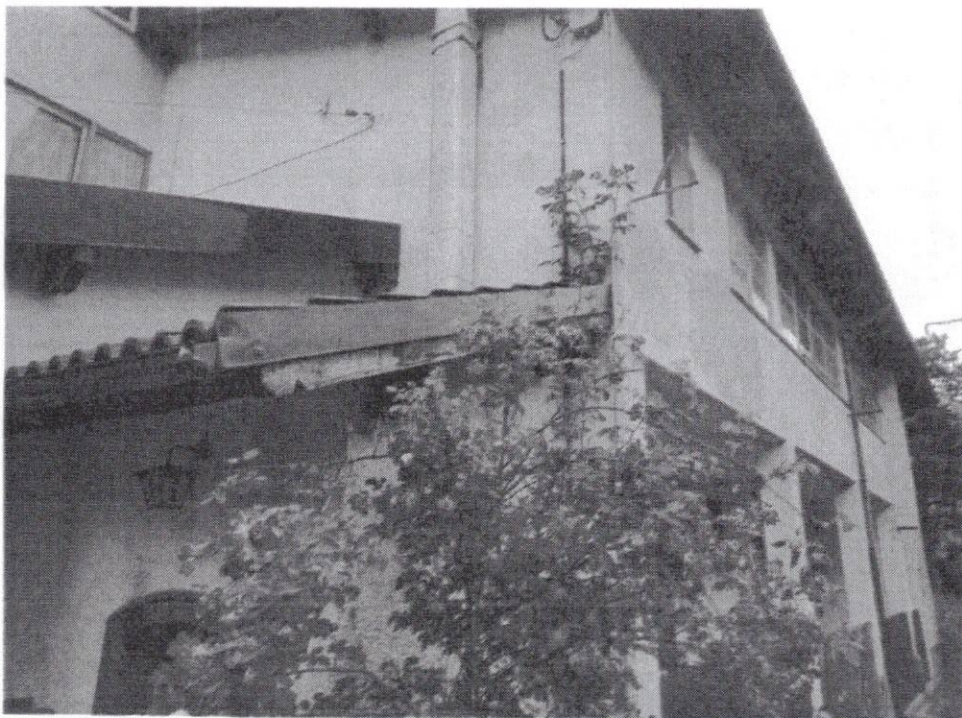
Scatto fotografico n.2 – lato a valle
