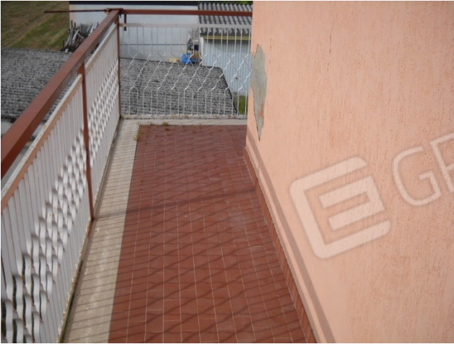
Balcone lato box
