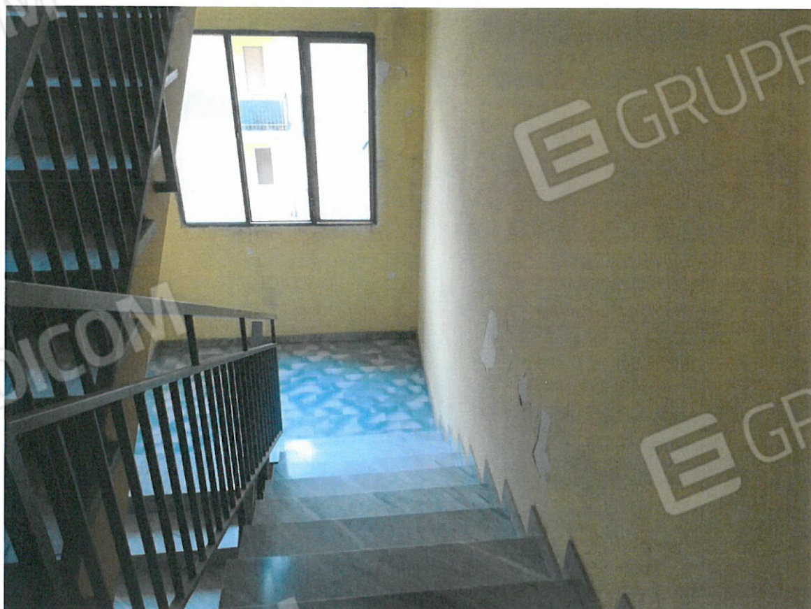
Foto n. 7_ Vano scala condominiale
