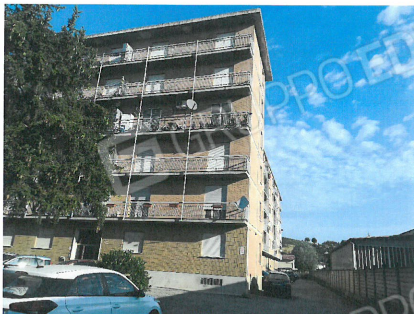
Foto n. 2 Condominio in cui è ubicata l'unità immobiliare oggetto di E.I.
