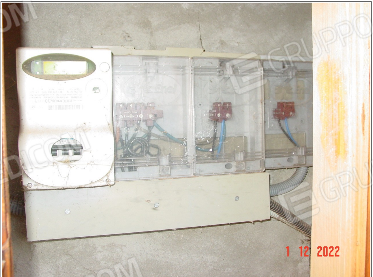
Particolare nicchia contatori energia elettrica
