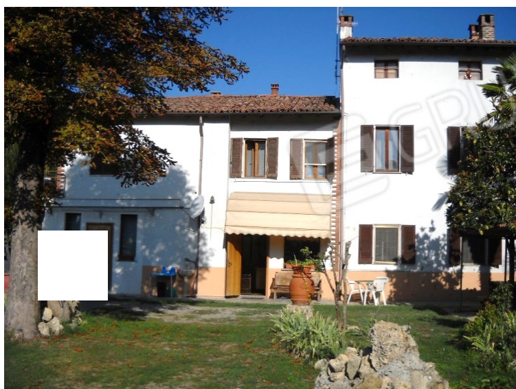
Prospetto da cortile interno
