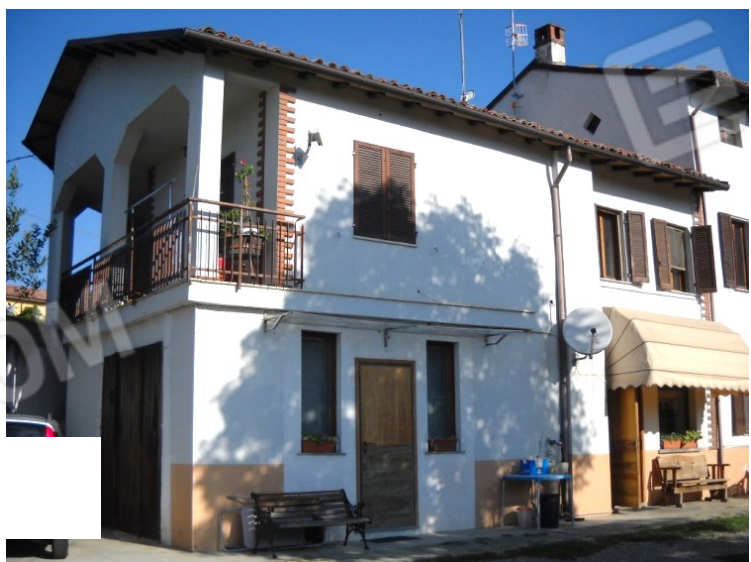
Prospetto da cortile interno
