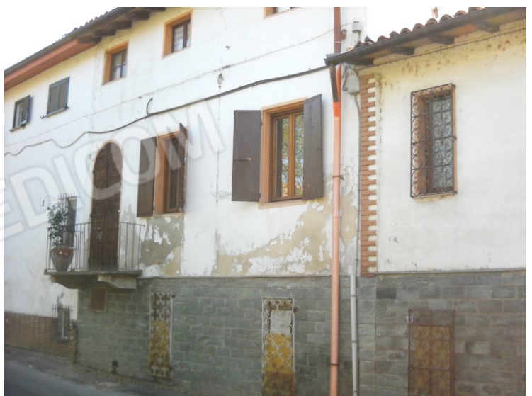
Prospetto da Via dei Mori
