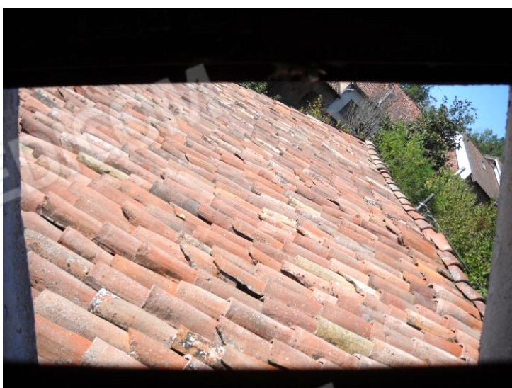
Manto di copertura in coppi
