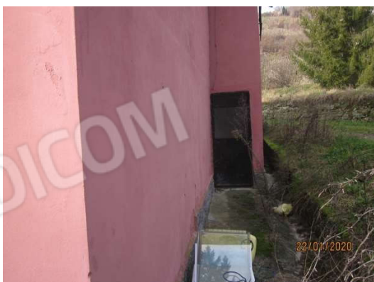
ingresso latrina e a destra finestra e ingresso cantina
