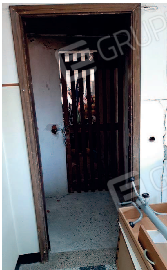
il ripostiglio al piano sottotetto
