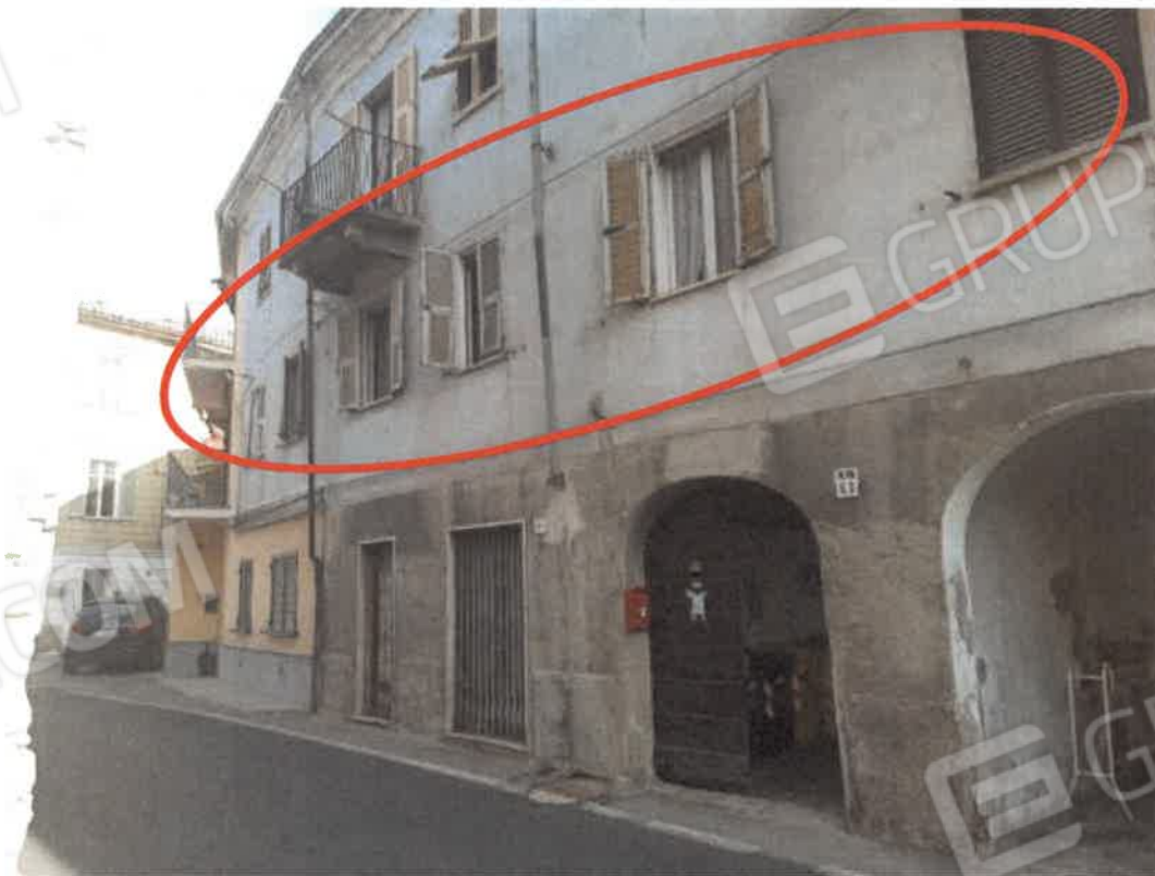
Vista dalla Strada pubblica del fabbricato urbano comprendente l'U.I.U. oggetto di esecuzione
