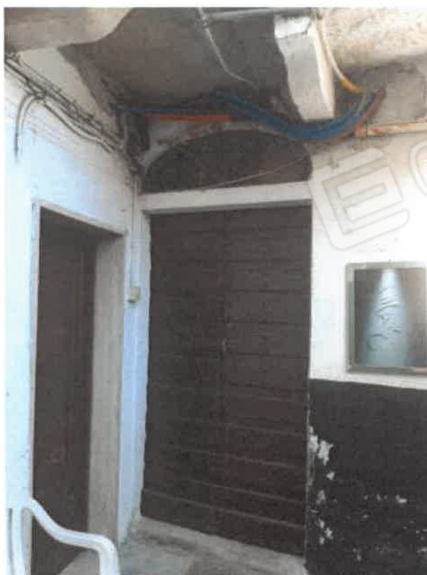
Vista da quota piano cortile del portoncino di accesso alla vano scala comune
