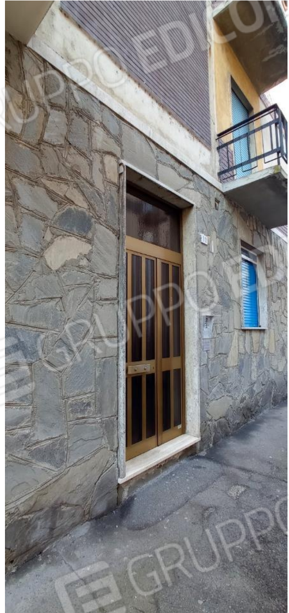
2. Portoncino di ingresso da strada
