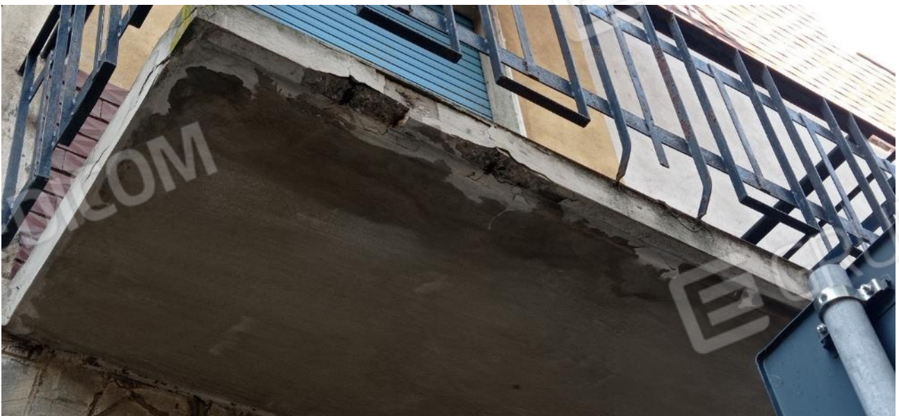
35. Dettaglio balcone su Via Fernandel
