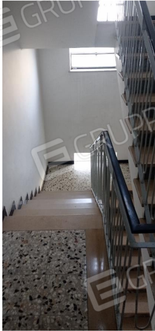
7. Vano scala condominiale
