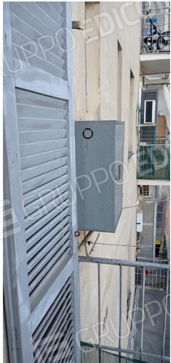
30. Balcone lato cortile interno
