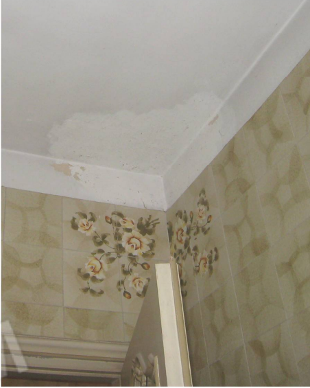
infiltrazioni dal servizio igienico nel sottotetto
