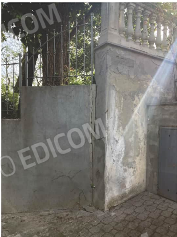
Stato fessurativo. All'interno alcune fessurazioni sono passanti e visibili anche all'esterno
