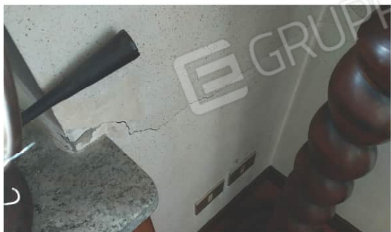
Stato fessurativo. All'interno alcune fessurazioni sono passanti e visibili anche all'esterno
