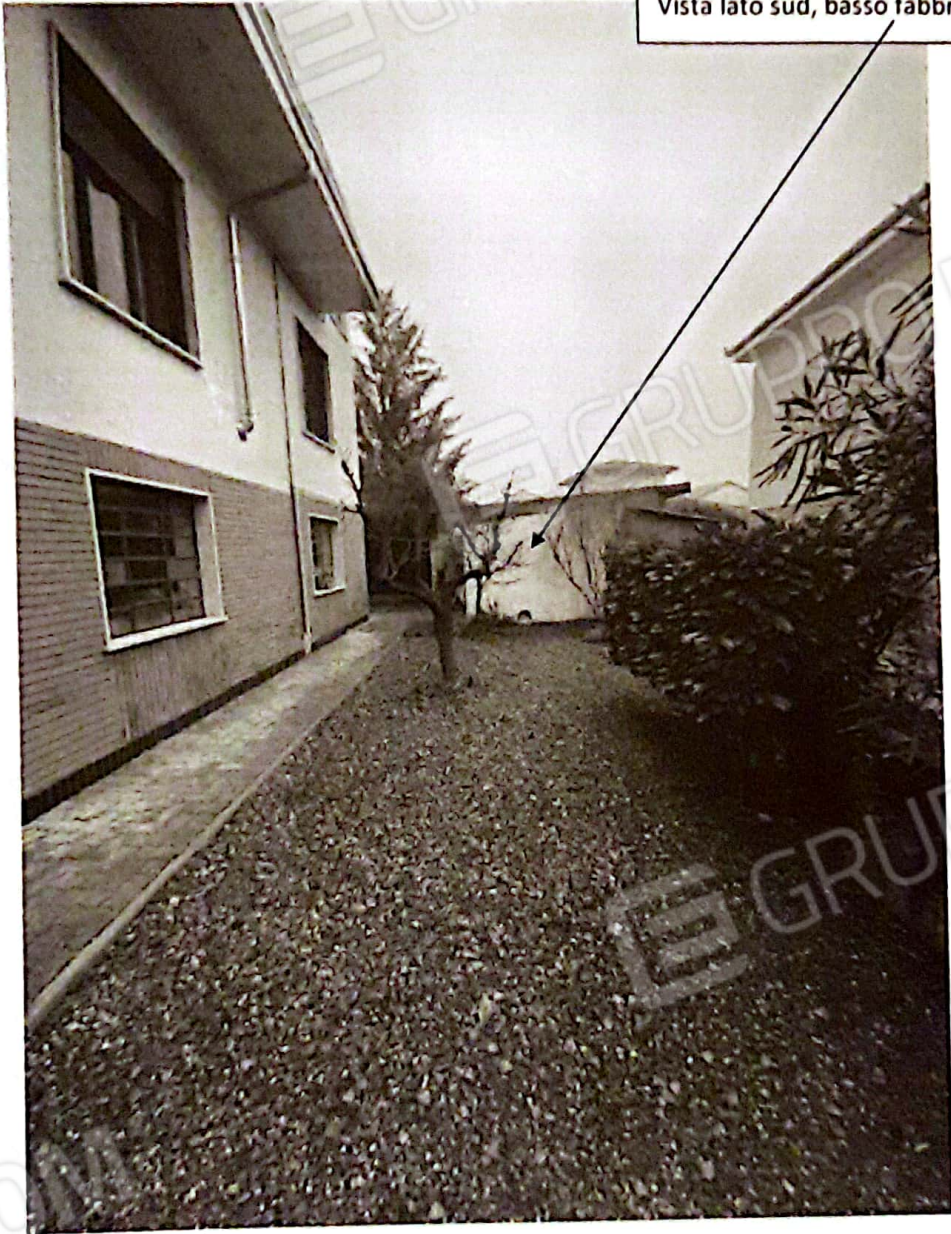
Vista lato sud, basso fabbricato
