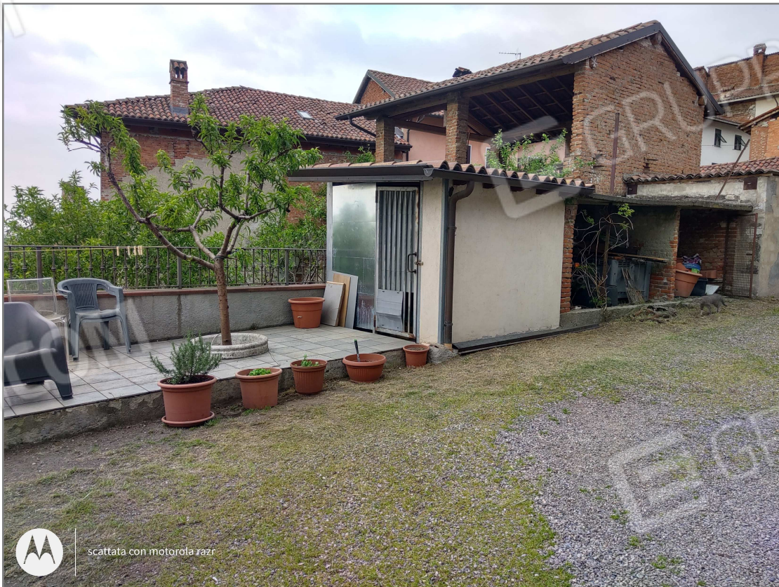
Vista su costruzioni interne al cortile insistenti su mappale 1151 [immobili privi di autorizzazione edilizia]
