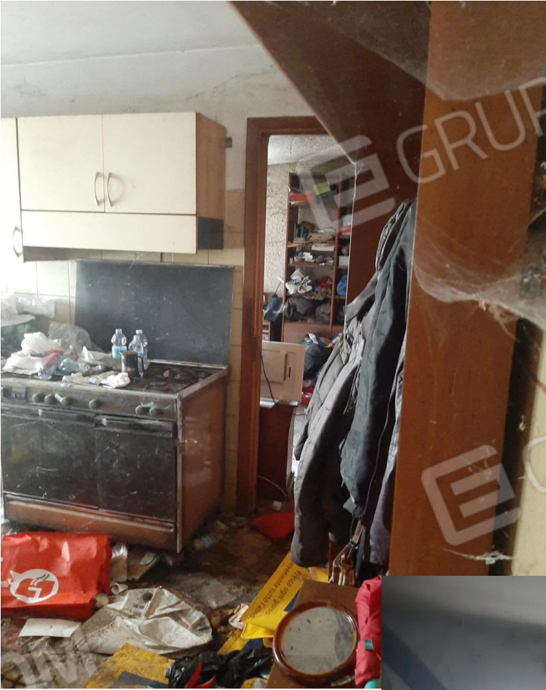
Stato di conservazione dell'interno
