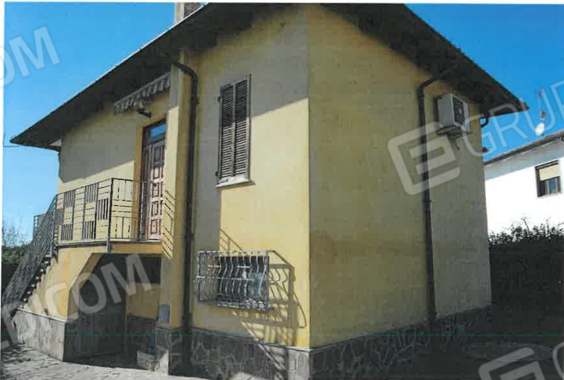
LOTTO 2 FABBRICATO UNIFAMILIARE VALMADONNA – Facciate esterne foto 20-21)
