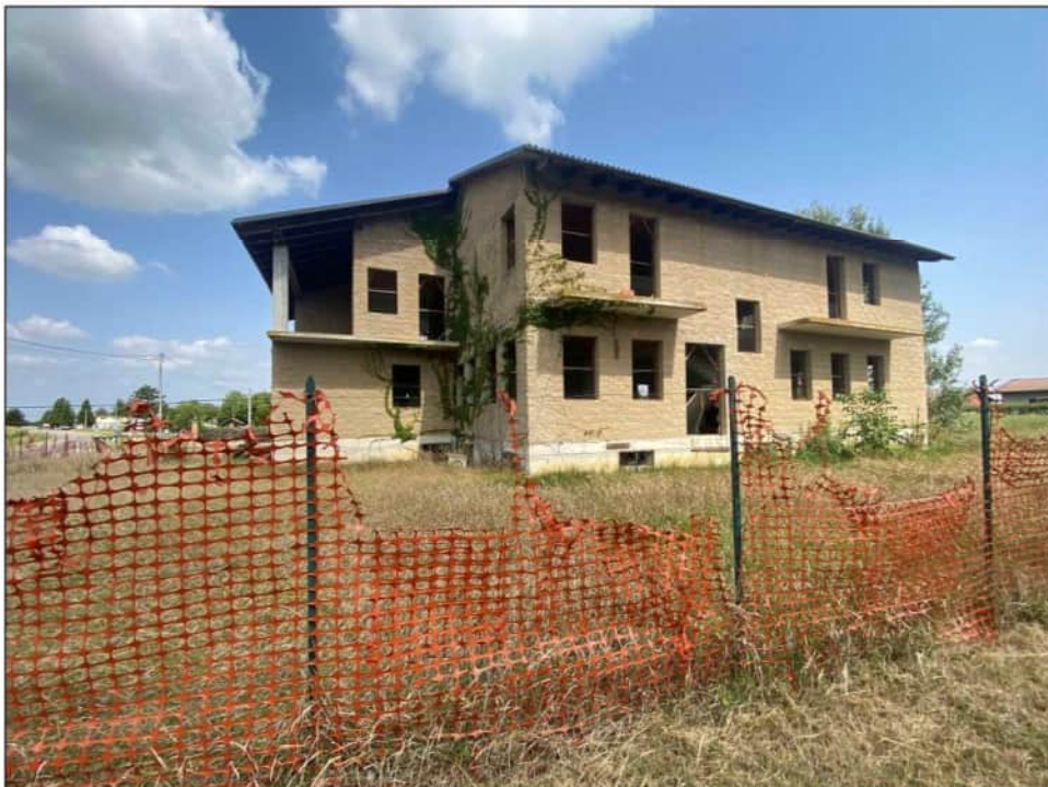
Immagine 6: Prospetto lato Sud Ovest
