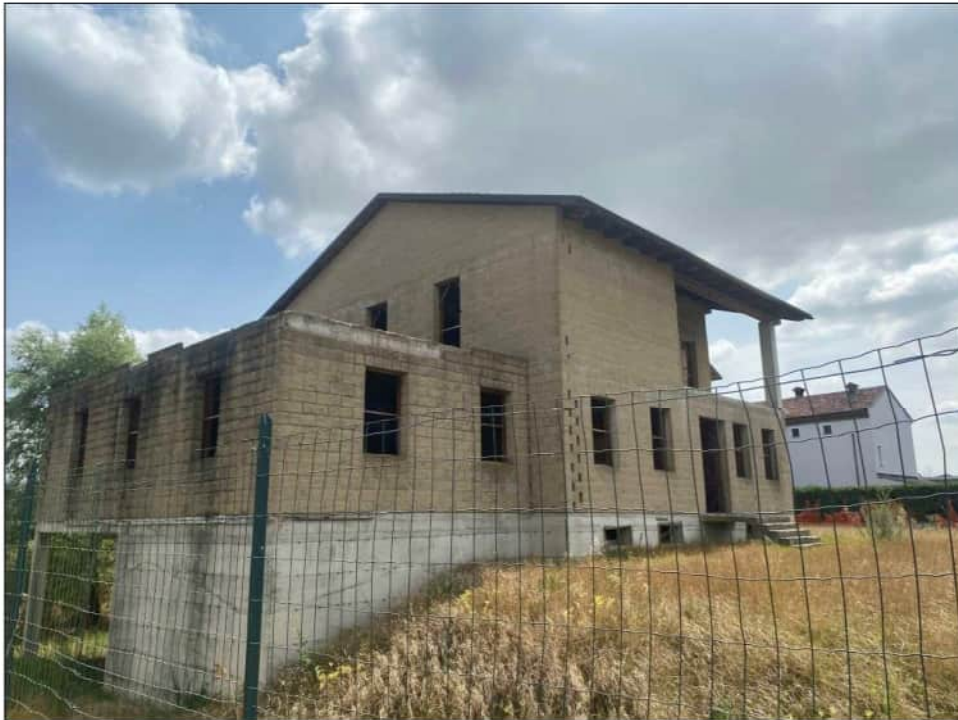
Immagine 5: Prospetto lato Nord Ovest
