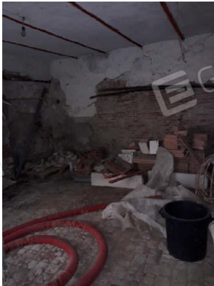
Vista interna situazione attuale locali destinati a magazzino / sgombero in piano terra
