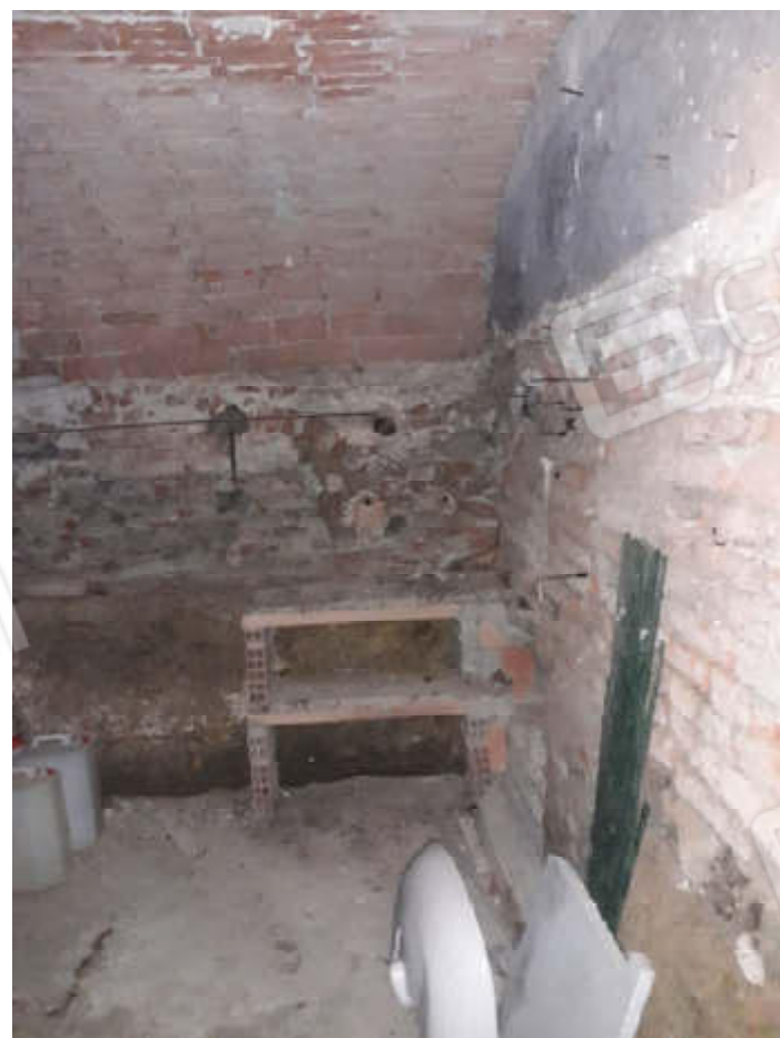
Vista interna situazione attuale locali destinati a cantina in piano primo sottostrada
