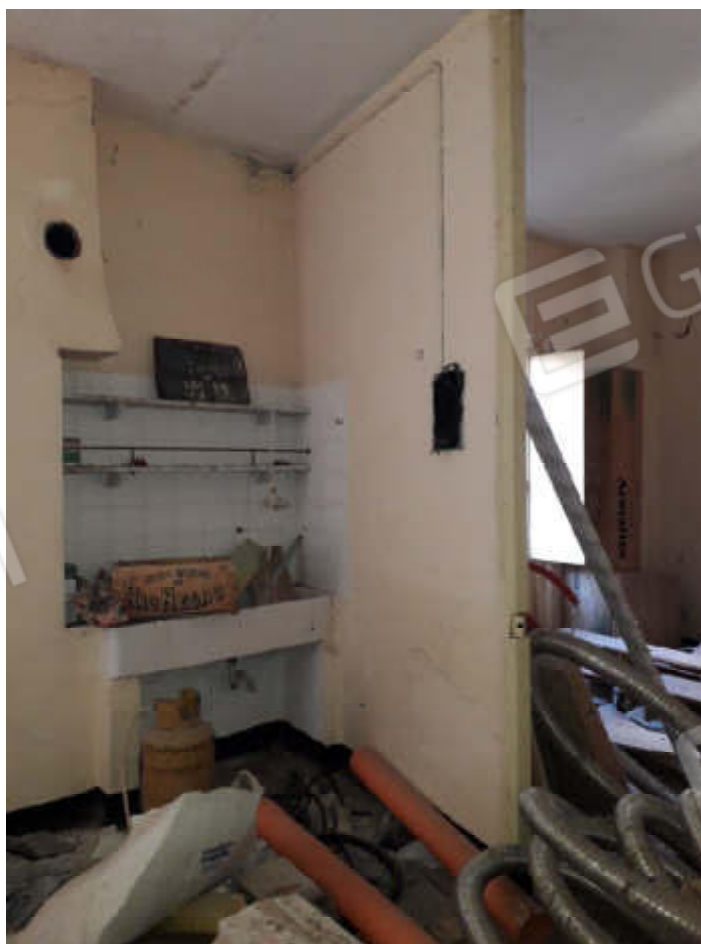
Vista interna situazione attuale locali destinati a magazzino / sgombero in piano primo
