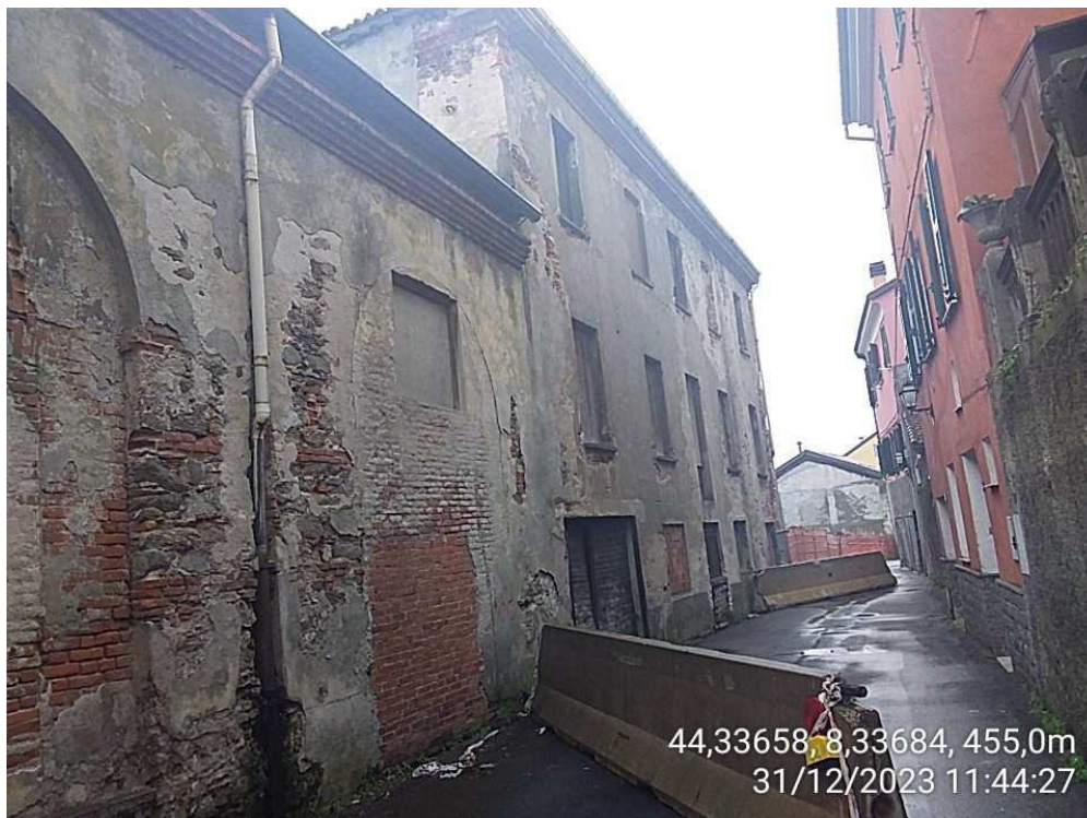
VIA CESIO CHIUSA E LAVORI MESSA IN SICUREZZA
