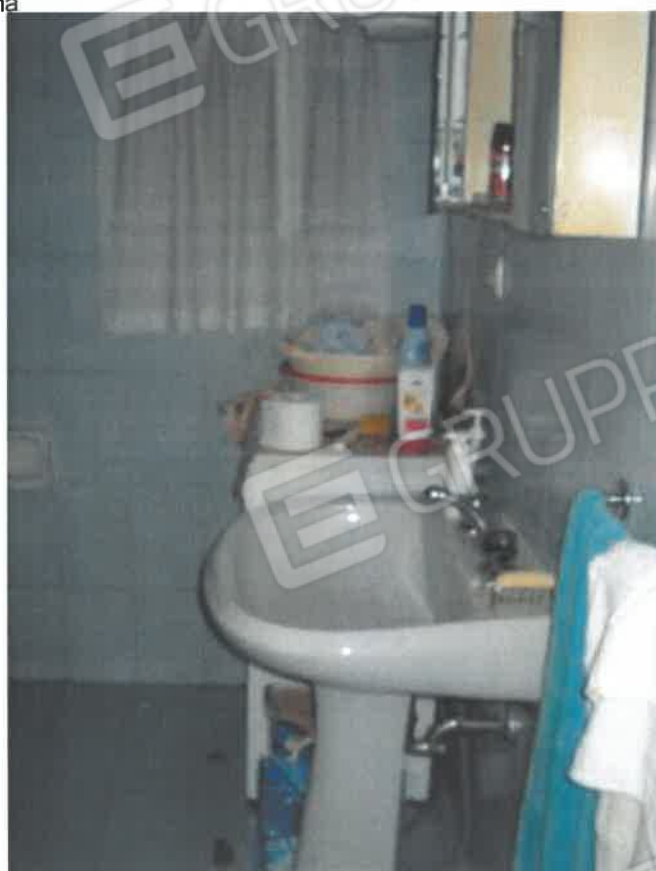
Foto 16 - immobile censito al fg.17 part.6 sub.1, bagno
