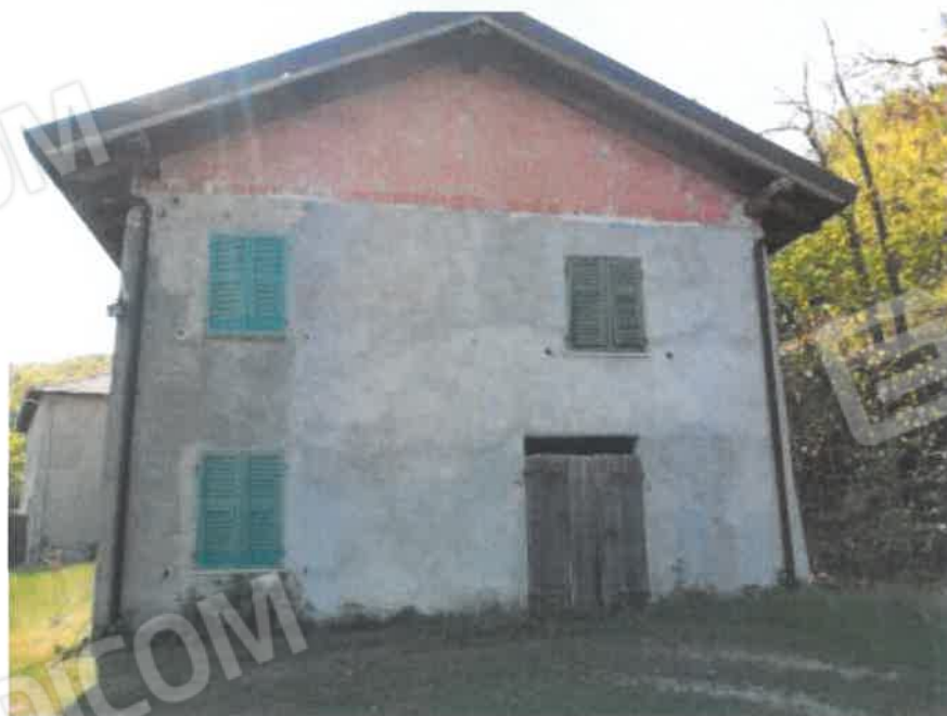
Foto 08- immobile censito al fg.17part.6 sub.1,
