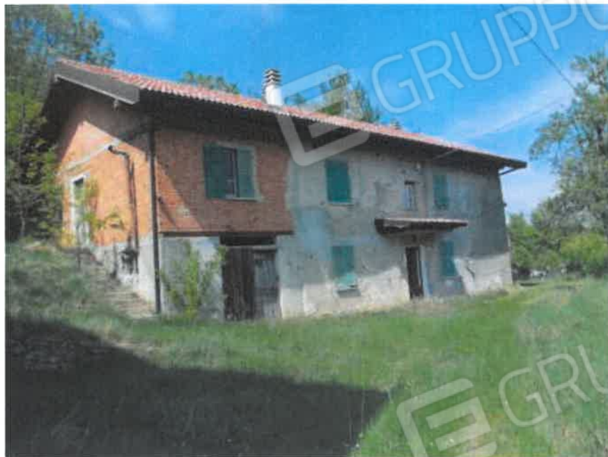
Foto 07 immobile censito al fg.17 part.6 sub.1, vista dal cortile
