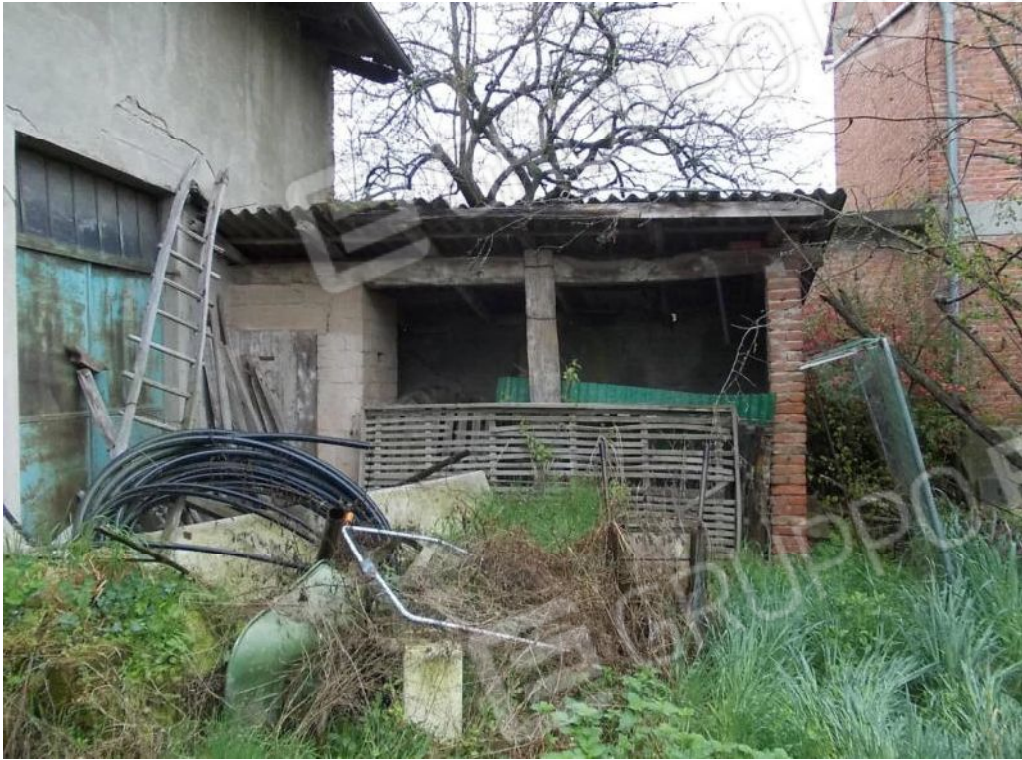
Foto 7 Prospetto est fabbricato mapp.336 sub.2 ripostigli (ex rurali)
