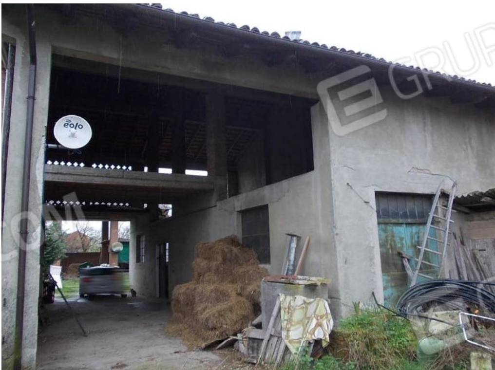
Foto 6 Prospetto sud fabbricato mapp.336 sub.2 locali sgombero/fienile (ex rurali)
