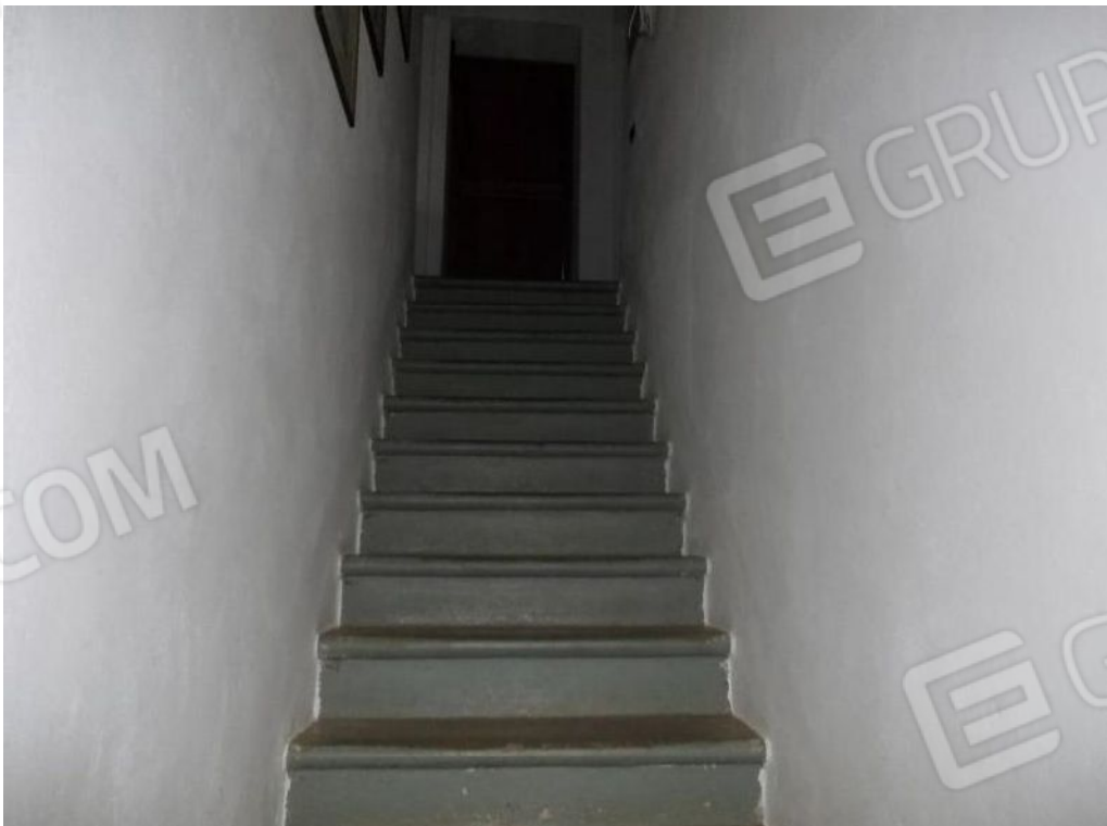
Foto 14 Ingresso abitazione mapp.336 sub.2 p.t.
