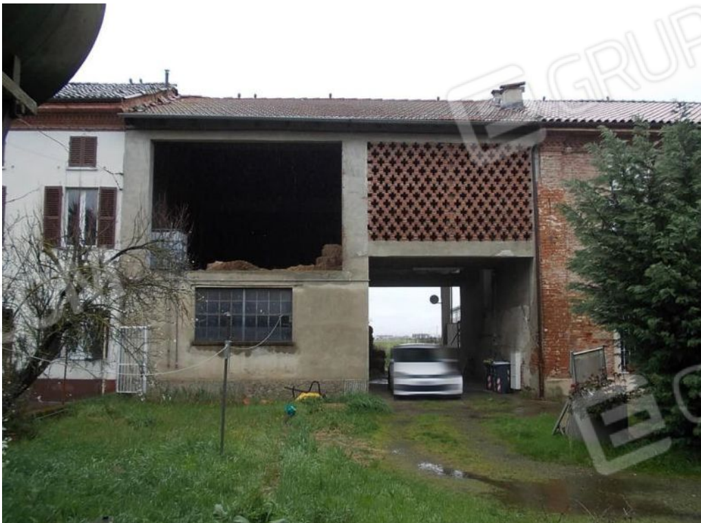
Foto 2 Prospetto sud fabbricato mapp.336 sub.2 locali sgombero (ex rurali)
