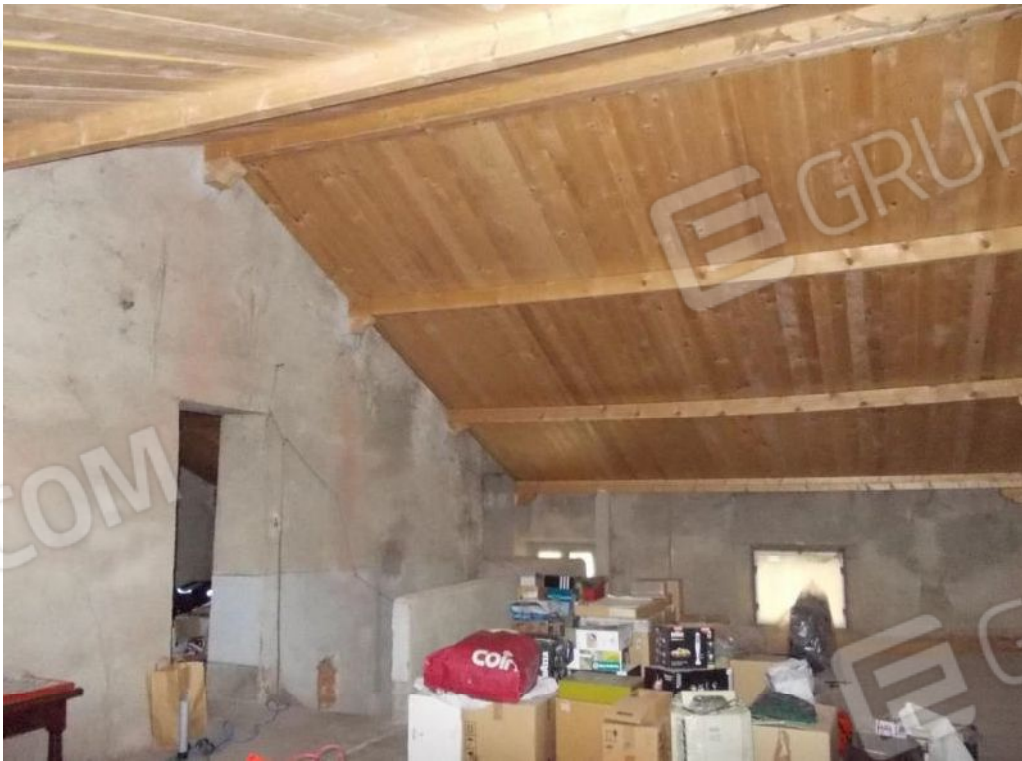
Foto 30 Locale sottotetto abitazione mapp.336 sub.2 p.1
