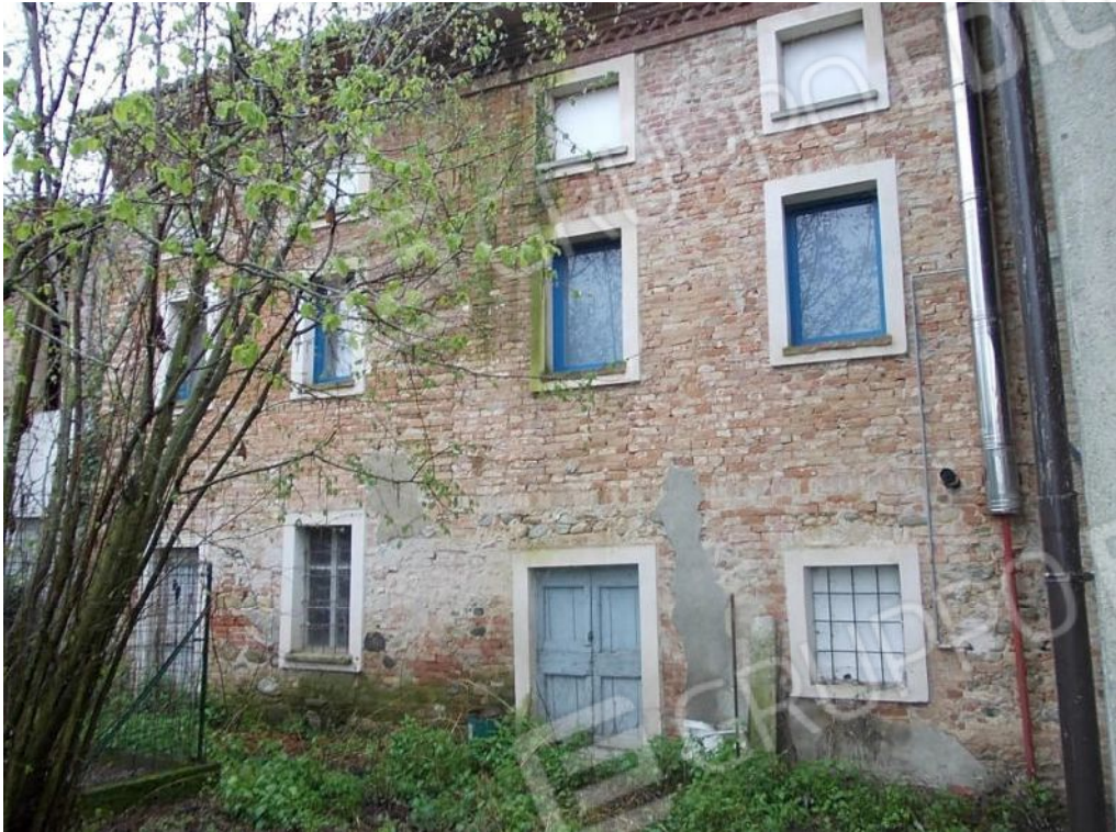
Foto 5 Prospetto nord fabbricato mapp.336 sub.2 abitazione
