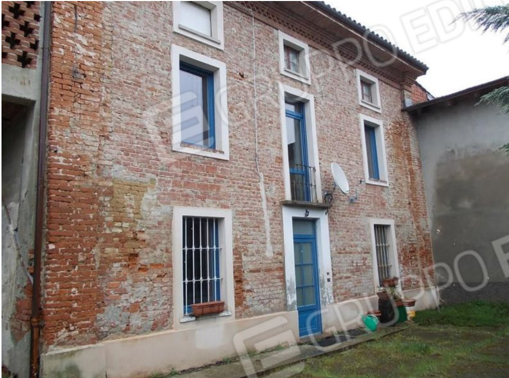
Foto 3 Prospetto sud fabbricato mapp.336 sub.2 abitazione
