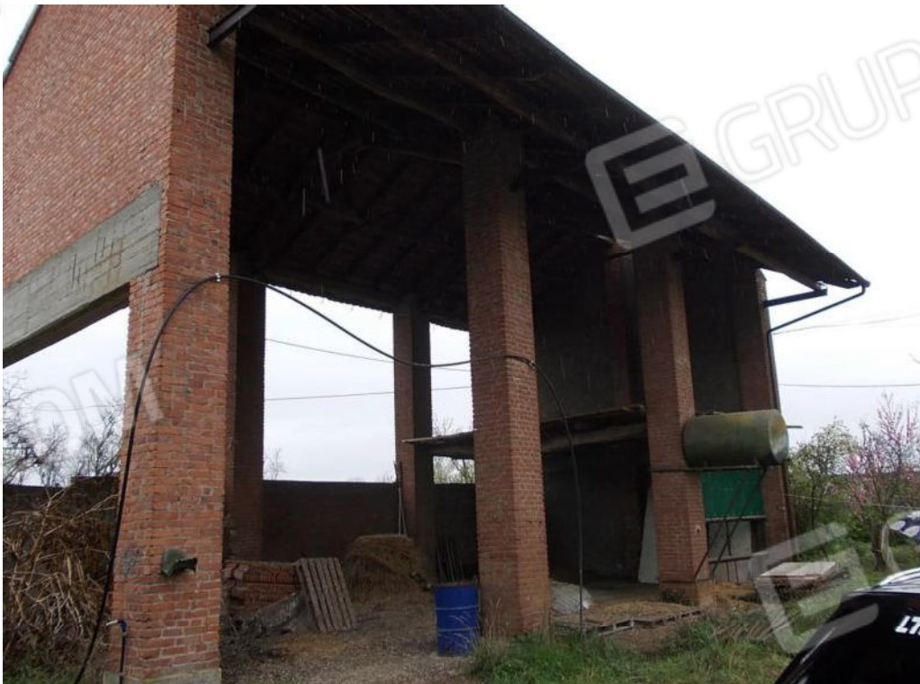
Foto 12 Prospetto nord/est mapp.336 sub.4 tettoia (ex rurale)
