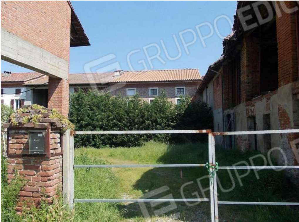
Foto 1 Ingresso fabbricati Cascina Moschina civ.18
