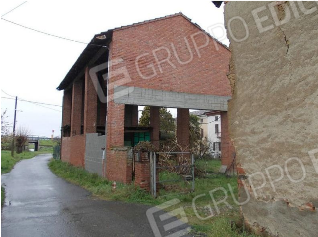
Foto 13 Prospetto sud/est mapp.336 sub.4 tettoia (ex rurale)
