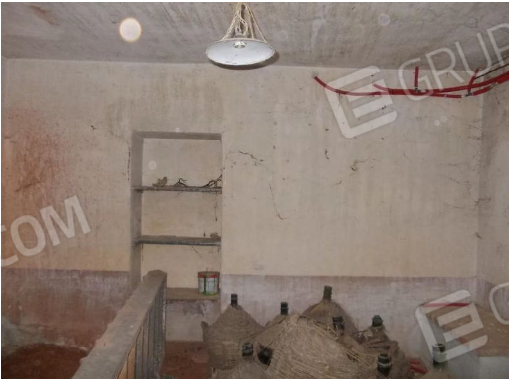
Foto 32 Locale cantina abitazione mapp.336 sub.2 p.t.
