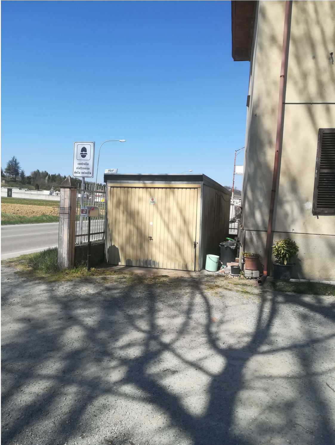
BOX prefabbricato da rimuovere
