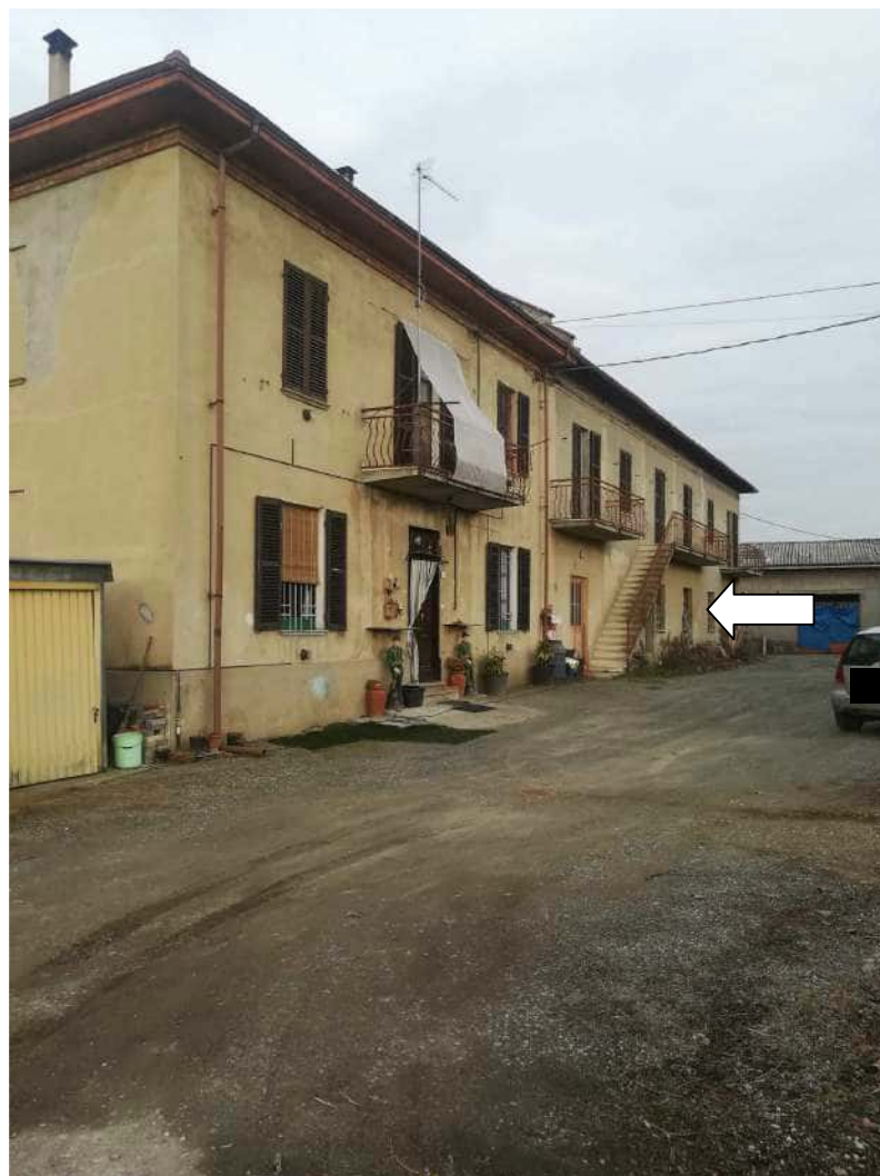
esterno sub 2( p.terra ) e scala accesso sub 8 ( p.1°)
