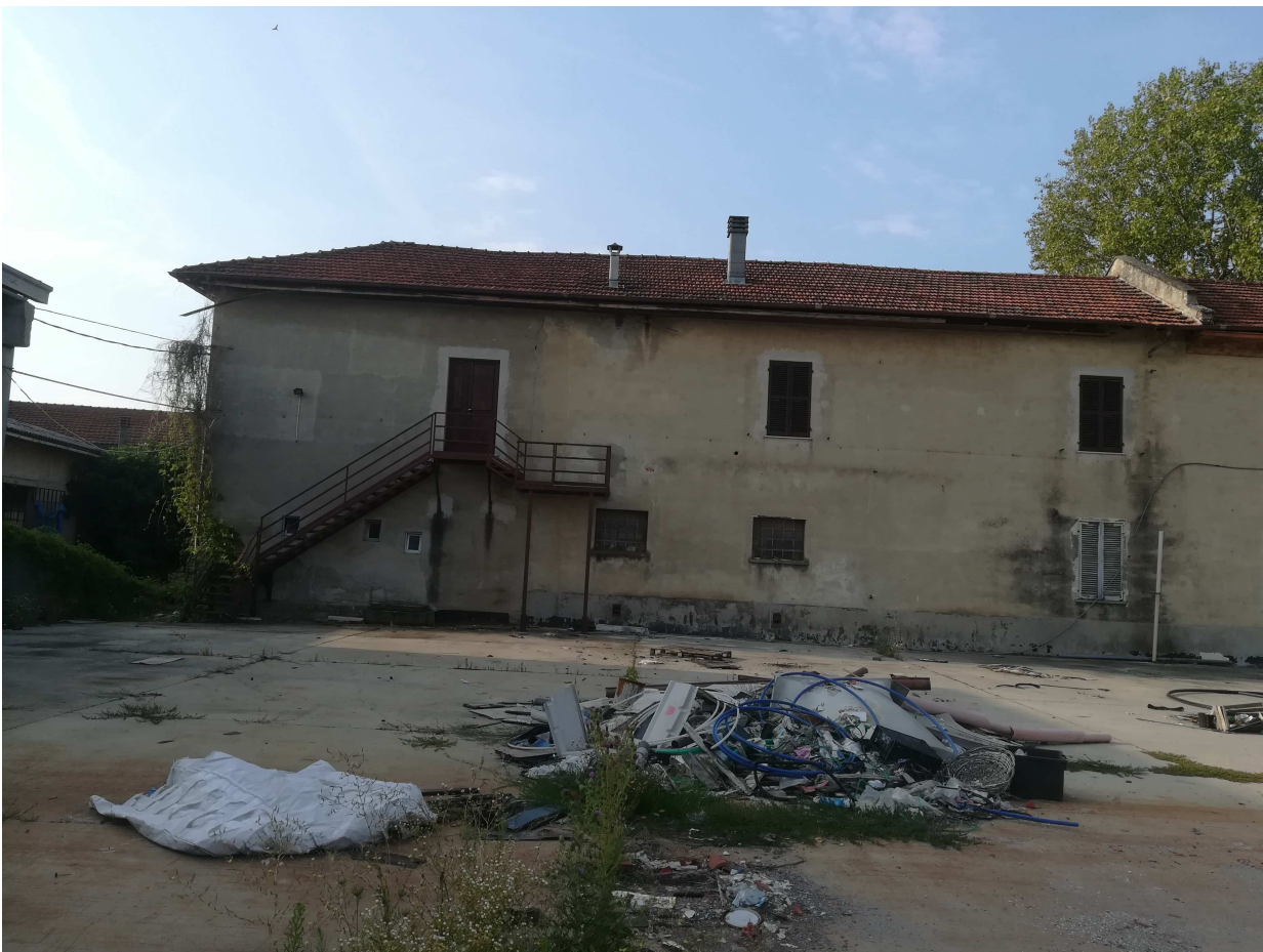
Accesso Sub 8 dalla corte del LOTTO 1 ( il Sub 8 ha accesso anche sul fronte dalla corte comune )
