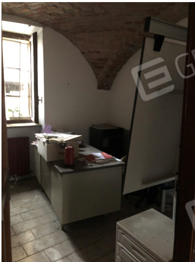
Foto n. 5 – Ufficio verso cortile interno
