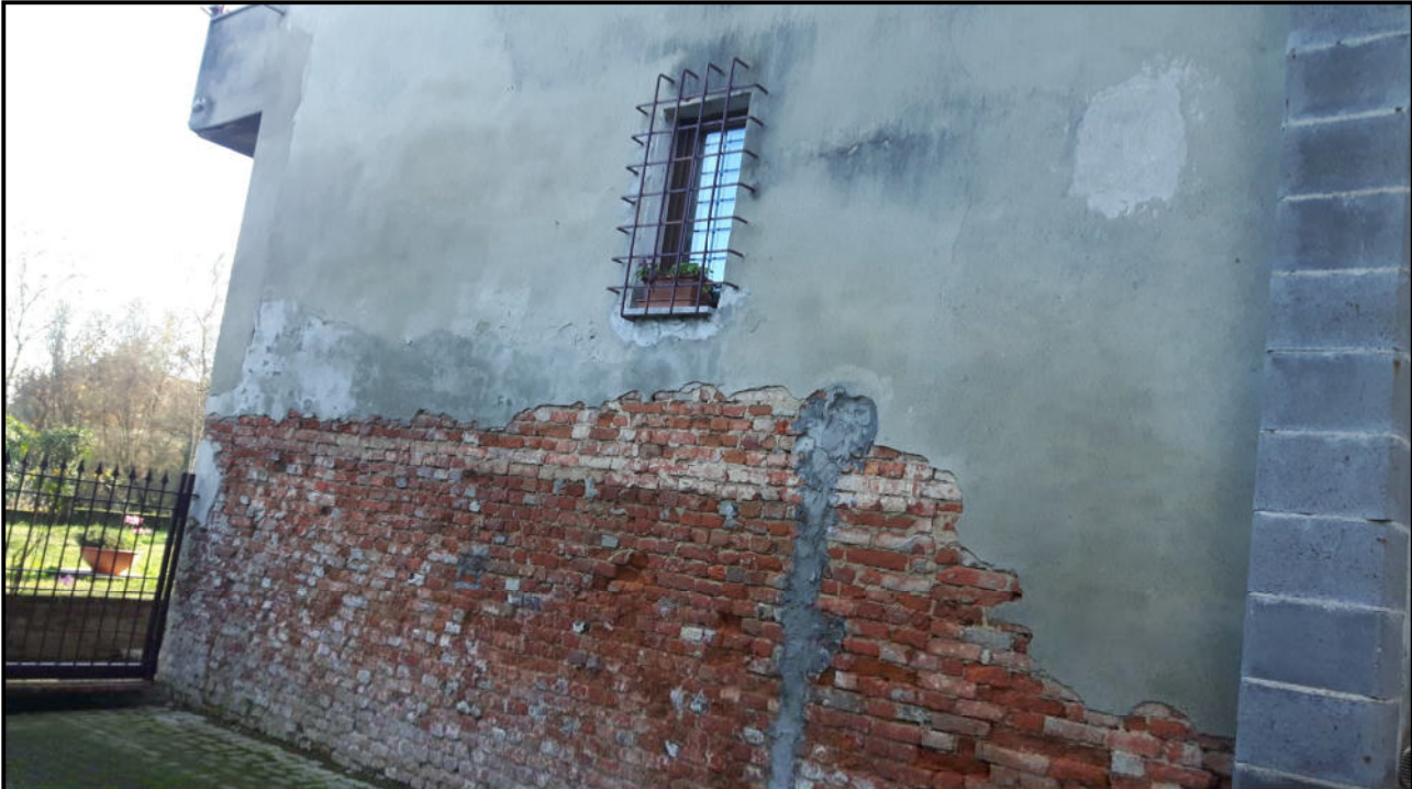
Figura 4: particolare facciata Nord / Est
