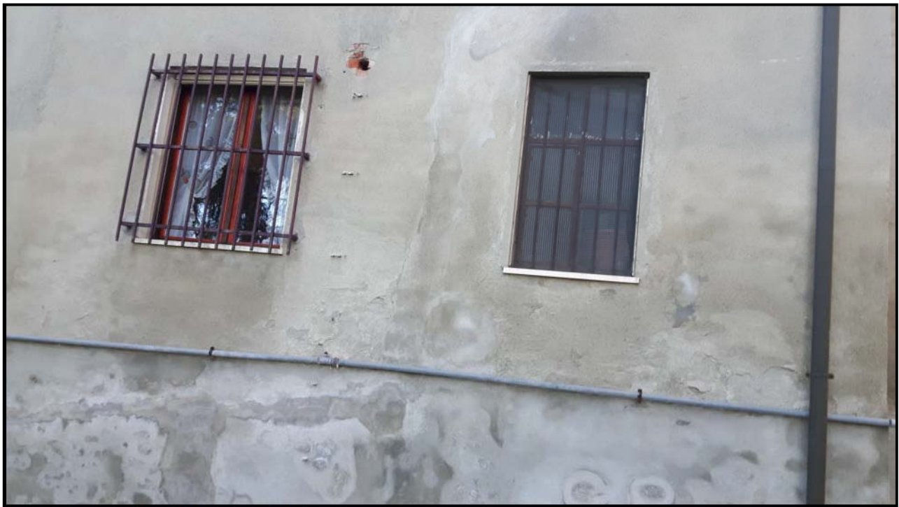
Figura 3: particolare facciata Nord / Est
