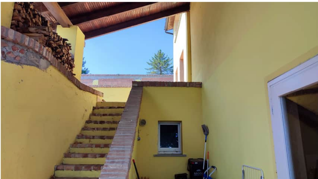
Accesso esterno al piano seminterrato - finestrella servizio igienico sotto scala/ingresso
