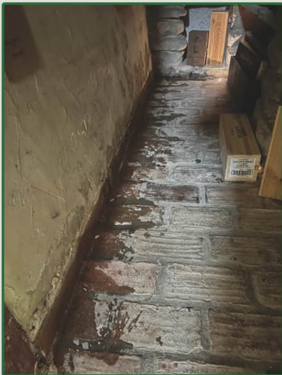
Muro e pavimentocantinetta a piano seminterrato - danni da infiltrazioni muro a confine con il bagno
