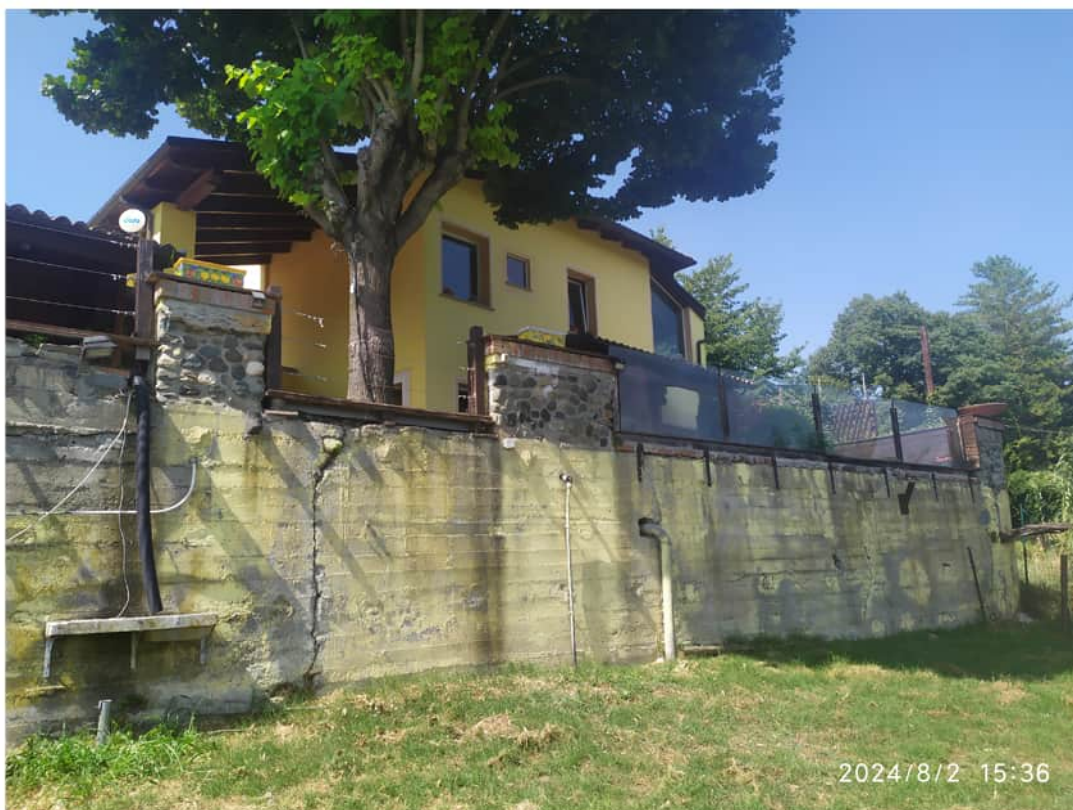
vista abitazione da primo terrazzamento e muro di sostegno
