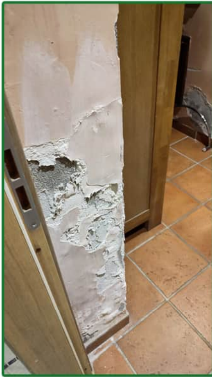
Danni da infiltrazioni - piano seminterrato
