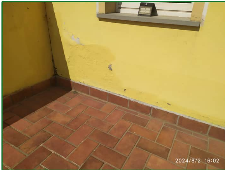
Muro esterno - ingresso principale all'abitazione - piano rialzato
