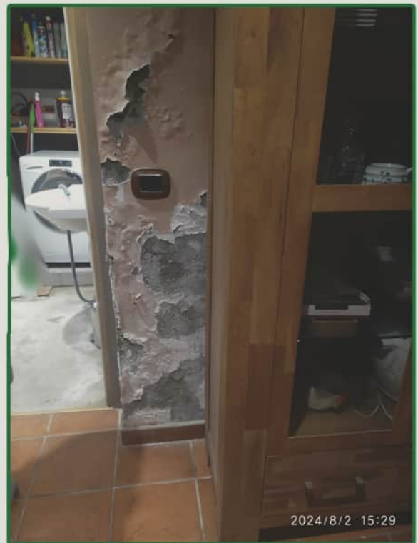
Muro e pavimentocantinetta a piano seminterrato - danni da infiltrazioni muro a confine con il bagno
