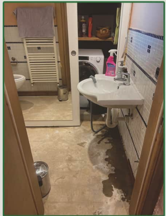
Situazione sottofondo pavimento bagno al piano seminterrato in data 02/08/2024 e confronto dopo breve precipitazione in data 07/08/2024.
