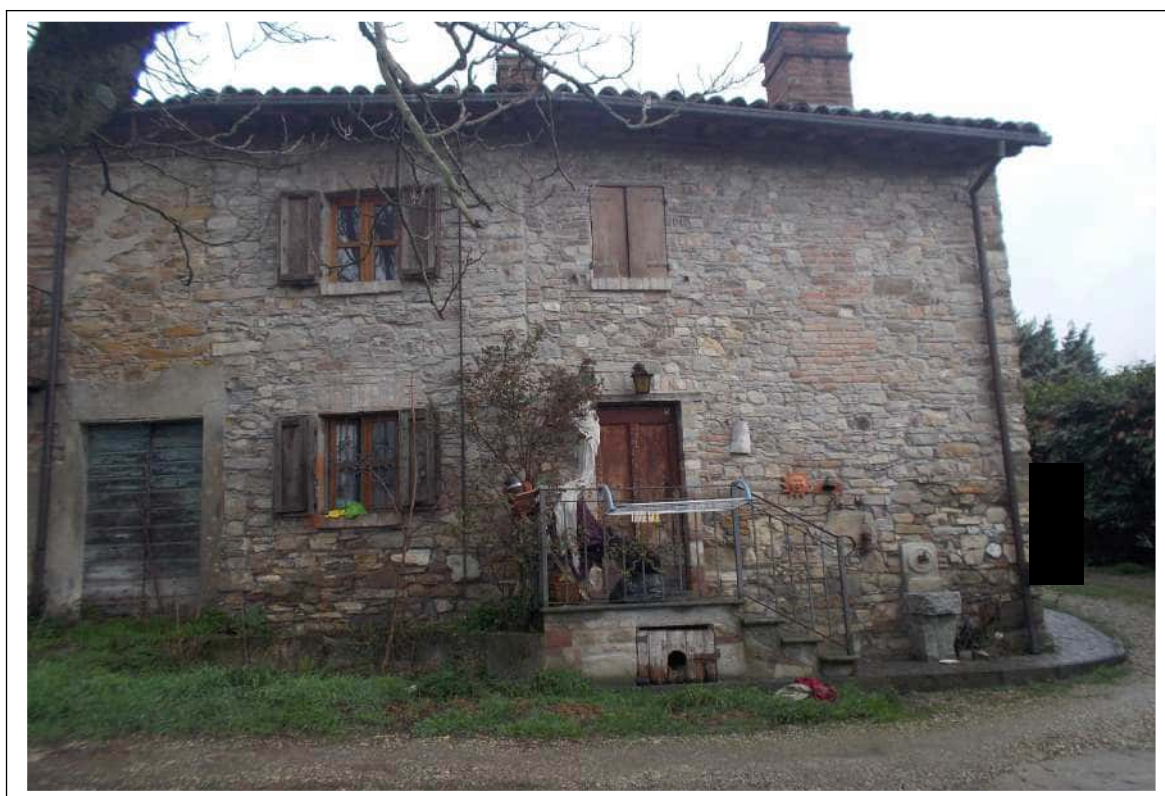
Fotografia n. 3 = LOTTO 1 CORPO A Vista del prospetto OVEST del fabbricato residenziale
