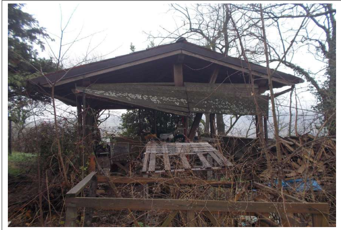
Fotografia n. 4 = LOTTO 1 CORPO B Vista del pergolato in legno
