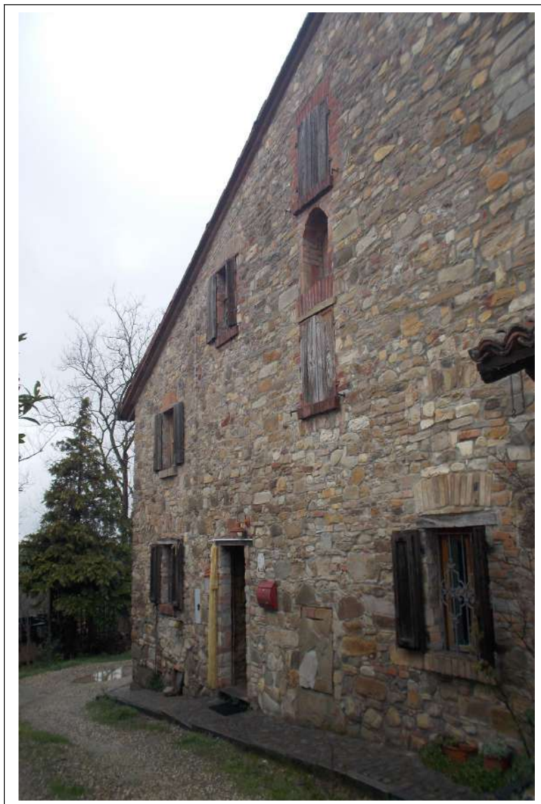
Fotografia n. 1 = LOTTO 1 CORPO A Vista del prospetto SUD del fabbricato residenziale
