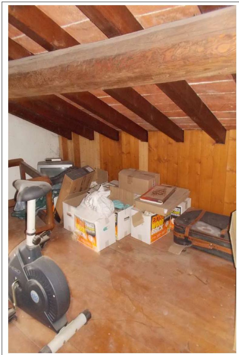
Fotografia n. 9 = LOTTO 1 CORPO A Vista interna di una camera al piano secondo
