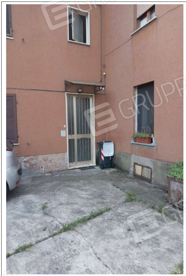
Fotografia n. 3 = LOTTO 1 CORPO A Vista dell'ingresso del fabbricato principale
