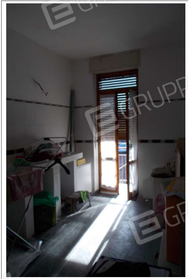
Fotografia n. 11 = LOTTO 1 CORPO A Vista interna del bagno
