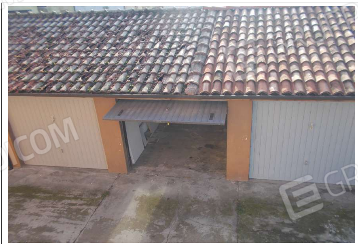
Fotografia n. 14 = LOTTO 1 CORPO B Vista particolare del manto di copertura del box
