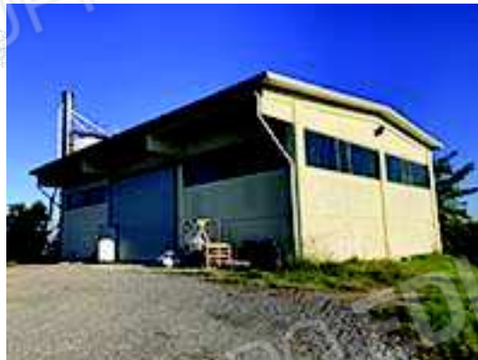
Foto 2: il capannone agricolo da sud
