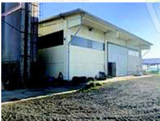
Foto 3: il capannone agricolo e i sili da nord
