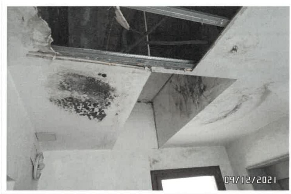
Particolare controsoffitto vano scala ammalorato Piano Secondo
