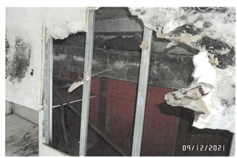
Particolare controsoffitto vano scala ammalorato Piano Secondo
