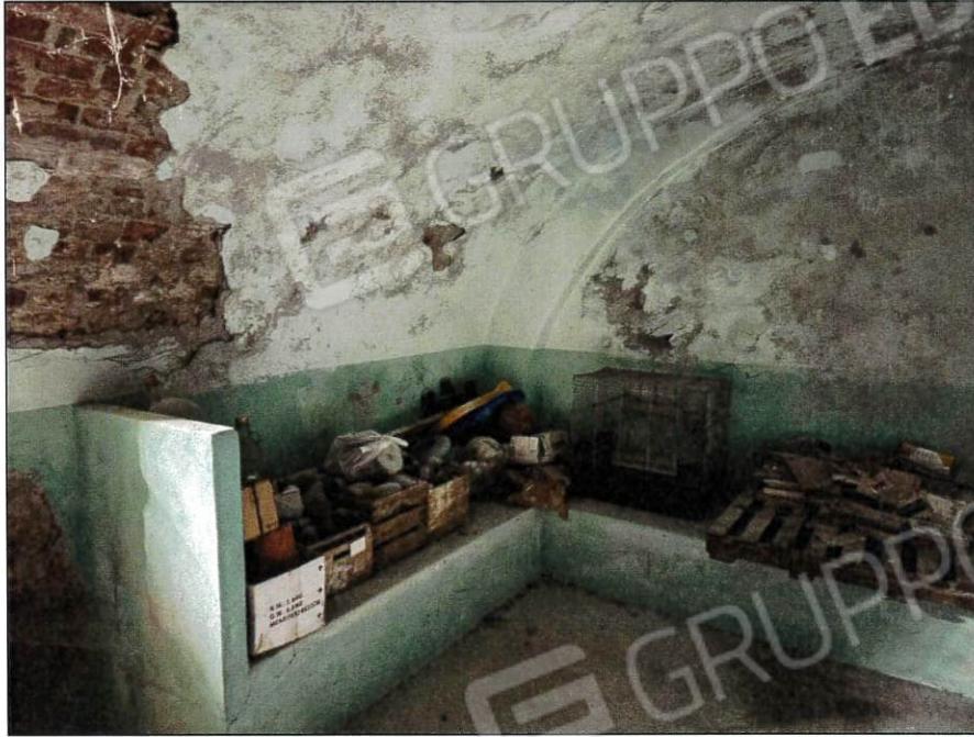
Immagine 31: Cantina piano interrato
