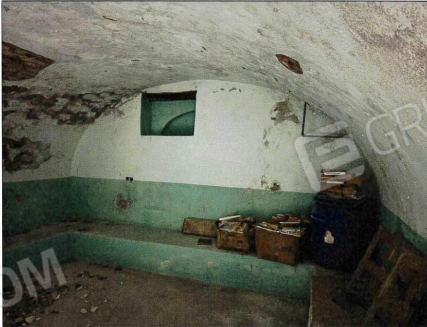
Immagine 30: Cantina piano interrato
