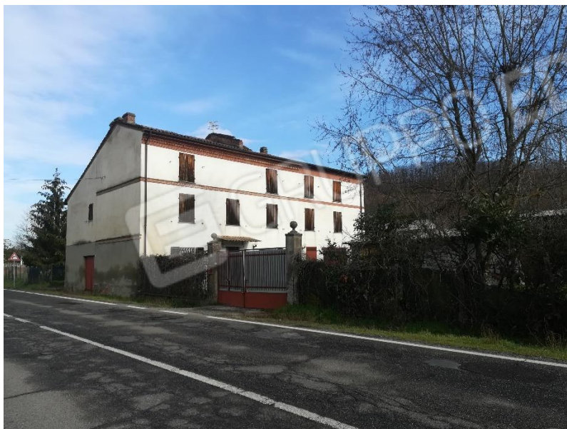
Foto n. 2_ Prospetto sud ed ovest
