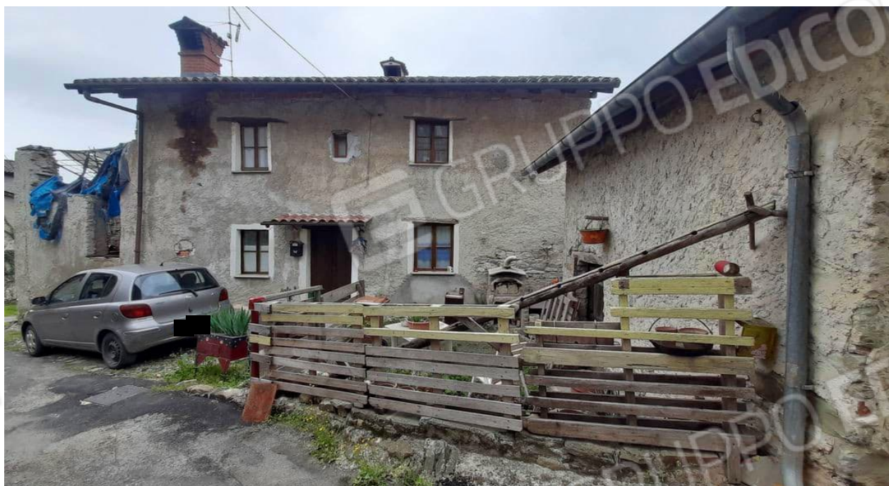
il fronte di ingresso e il ricovero attrezzi in primo piano
