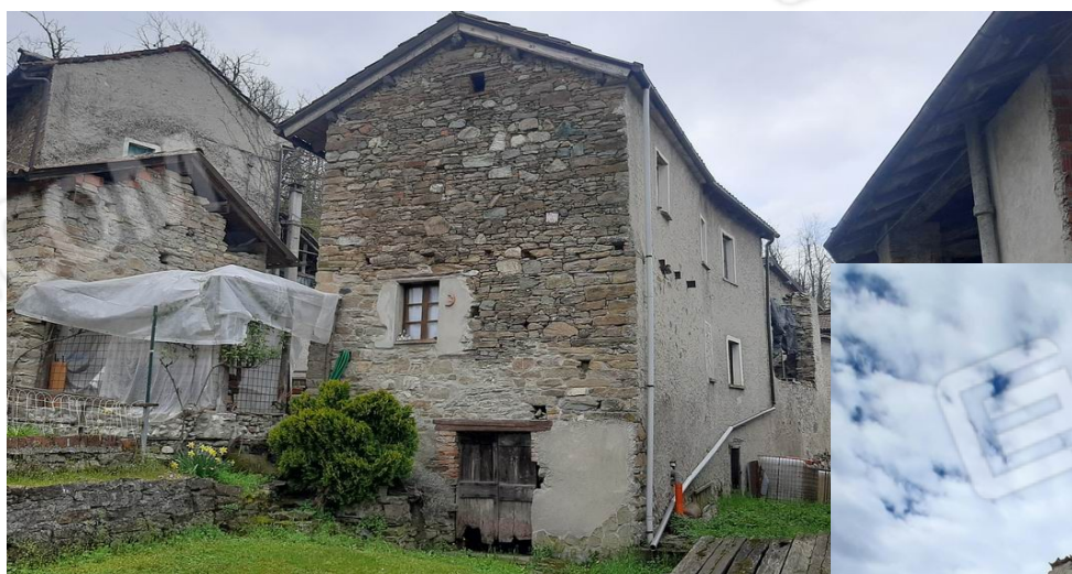
la testata nord
