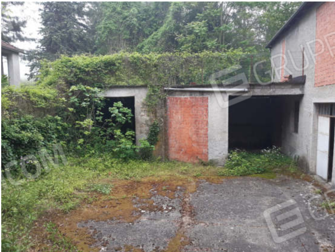
Vista dal cortile interno della situazione attuale di manutenzione dei fabbricati
