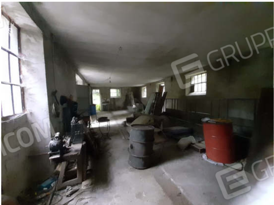
Vista interna locale deposito accessorio in piano terra
