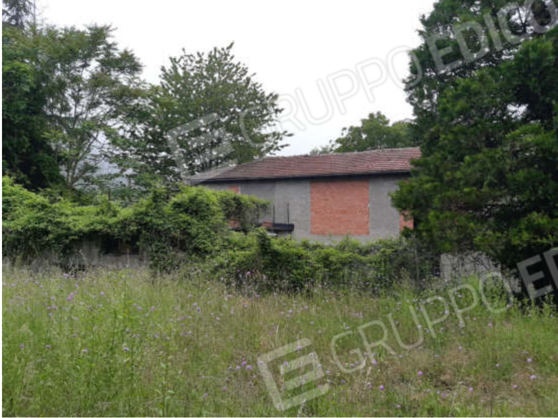
Vista da cortile antistante al fabbricato, della situazione attuale di manutenzione dell'area
