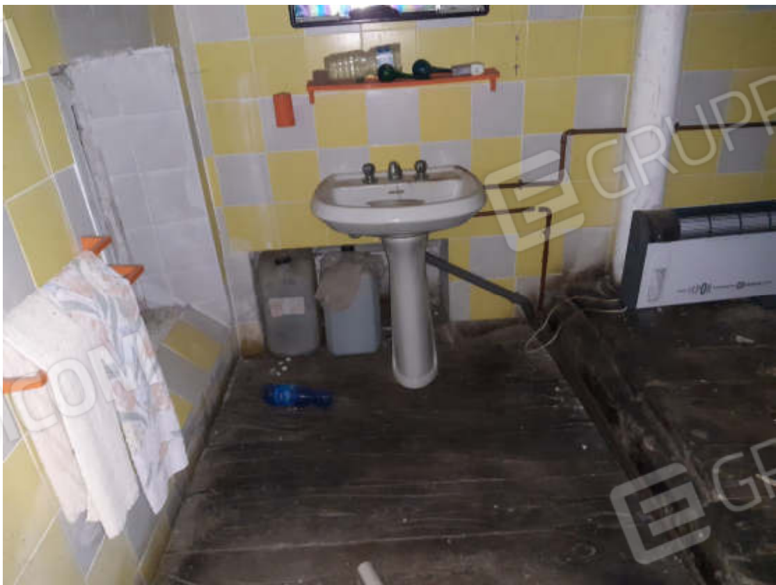
Vista interna locale bagno in piano secondo
