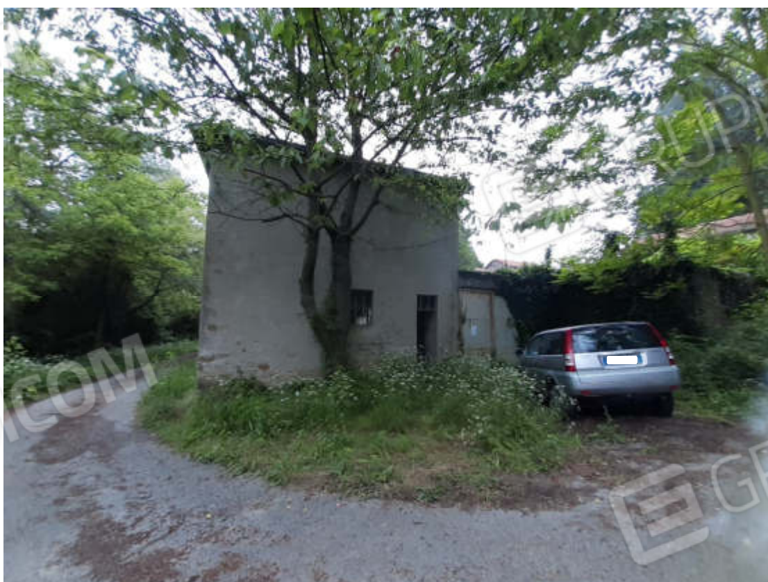
Vista esterna del fabbricato e della strada di accesso
