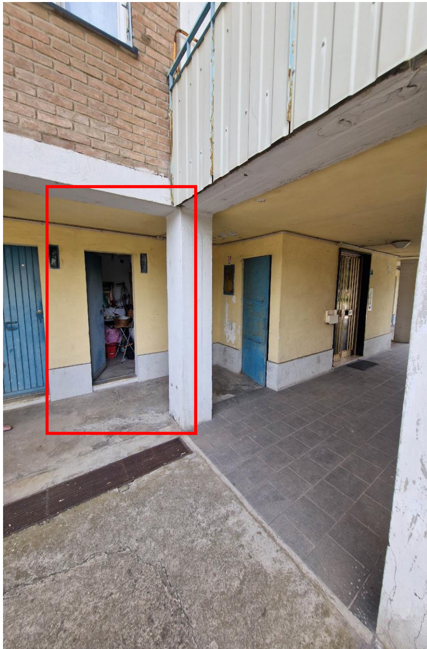
Foto n° 3 – CONDOMINIO IN OGGETTO CON INDIVIDUAZIONE CANTINA – VISTA NORD/EST
