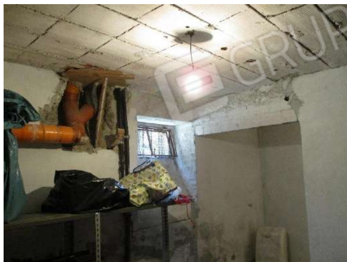
Vista della cantina piano semi – interrato
