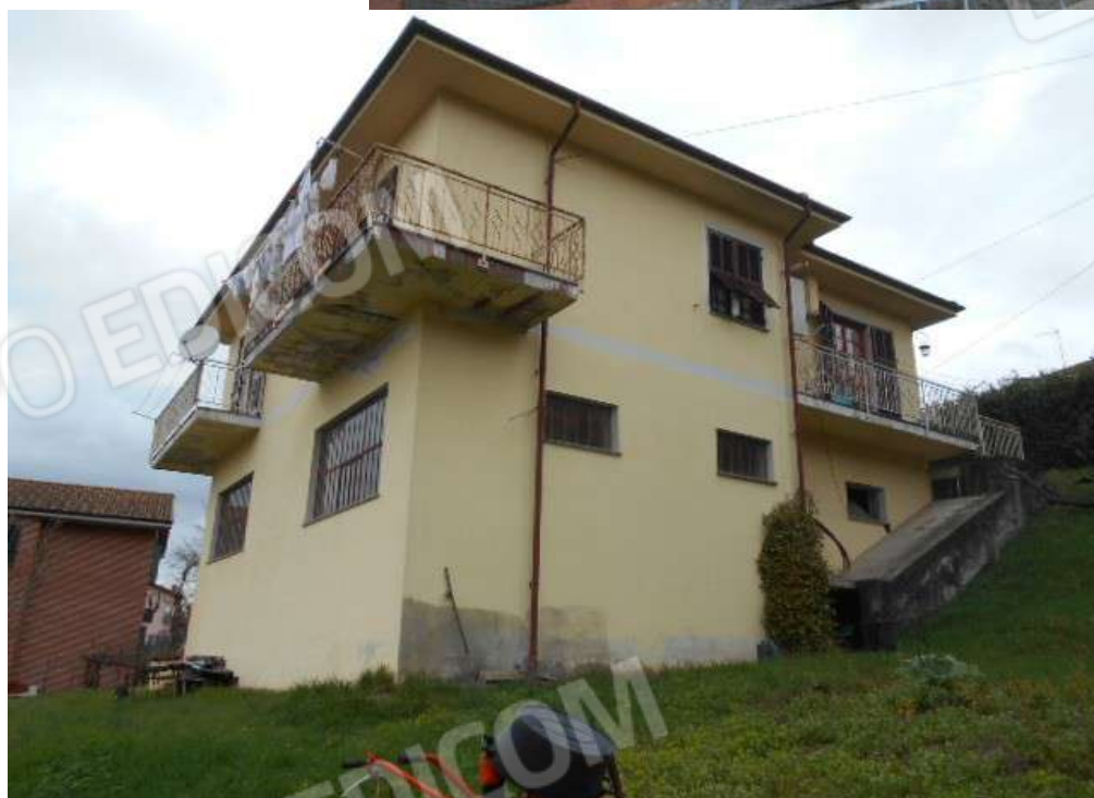
i fronti sud-ovest e sud-est rivolti a valle
