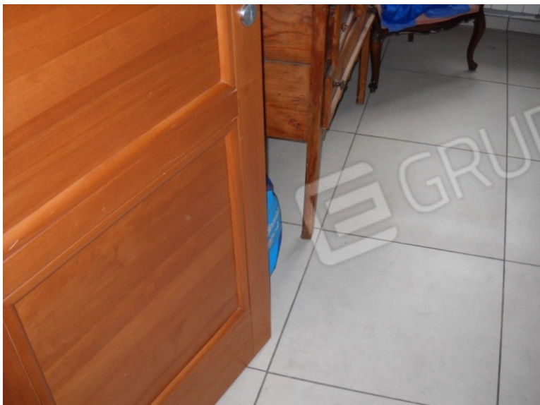
Dettaglio porte interne
