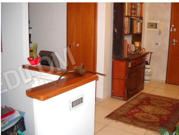
Tramezza rimossa zona cucina
