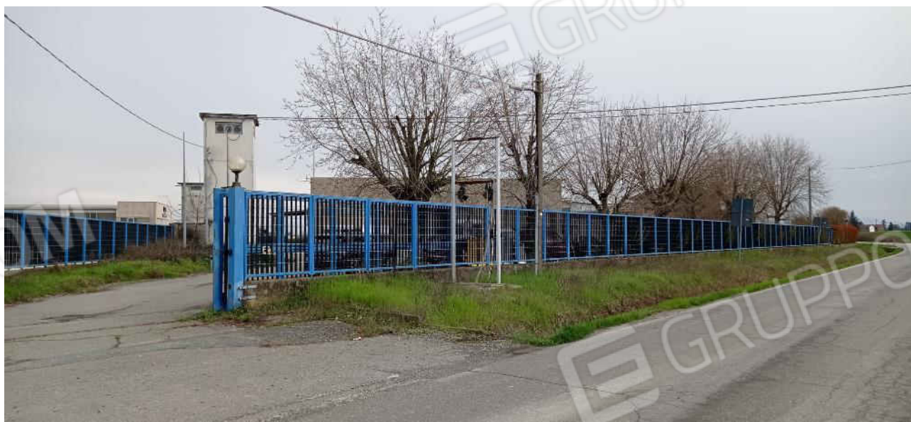
43-Vista nord ingresso verso esterno
