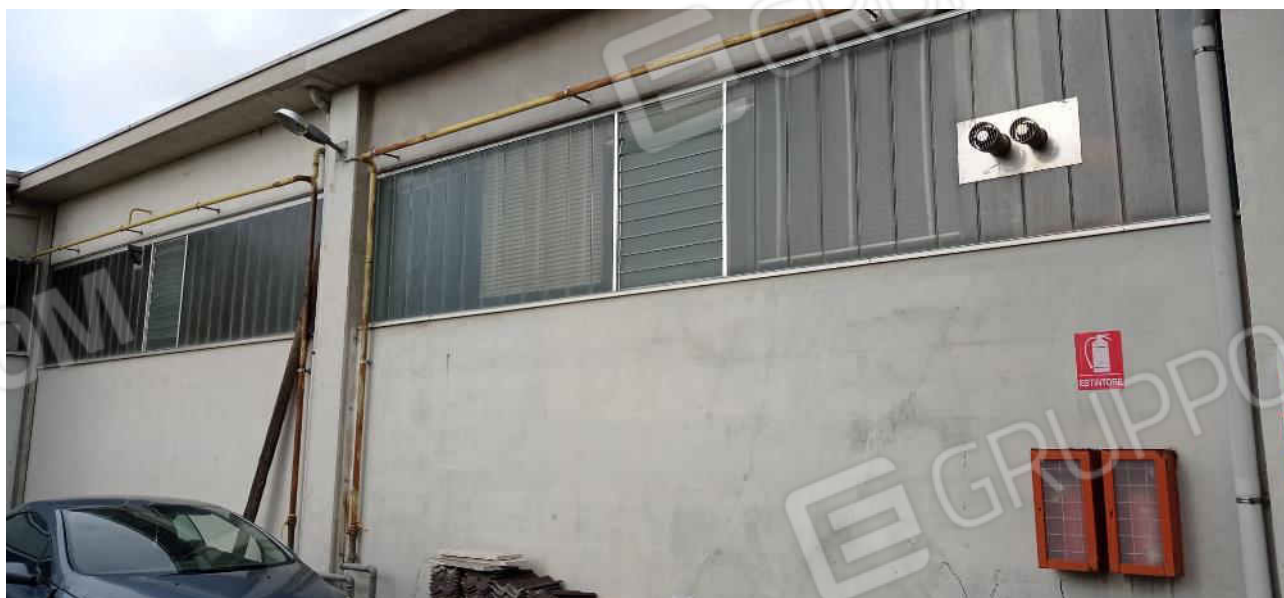
6- Vista esterna capannone
