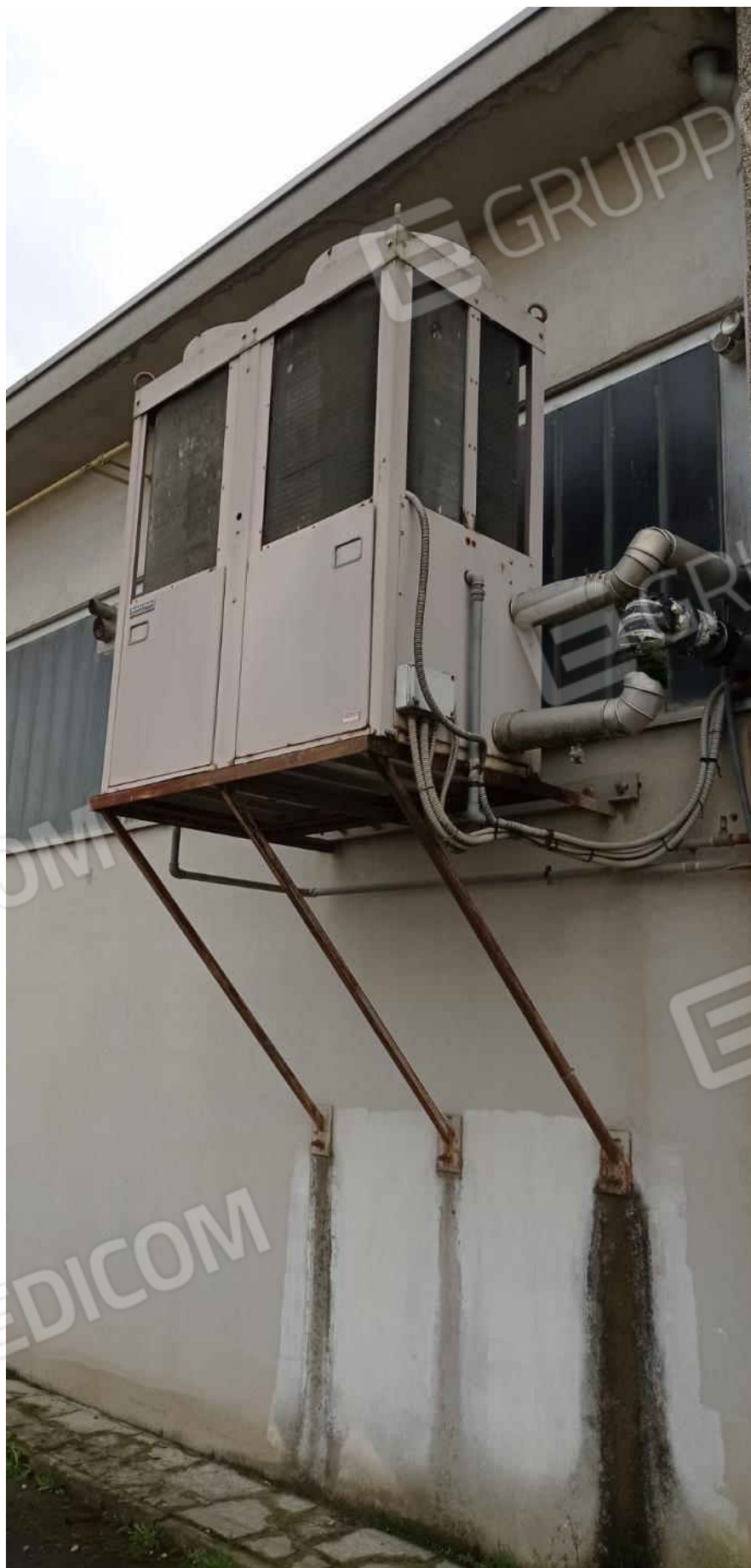
39-Vista esterna capannone
