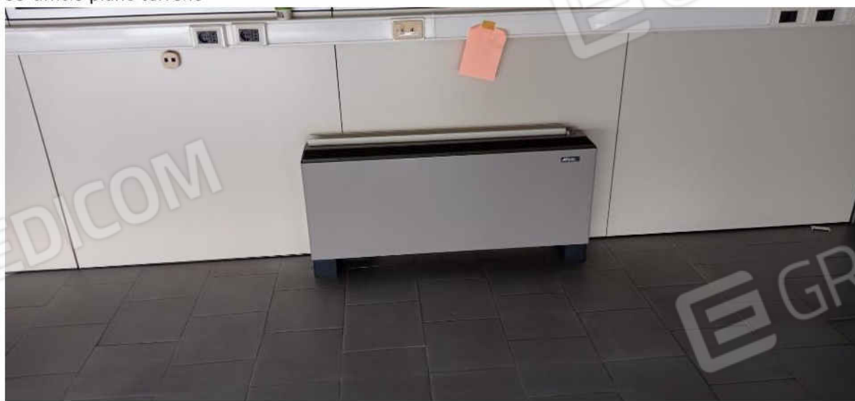
54-dettaglio impianto di riscaldamento piano primo
