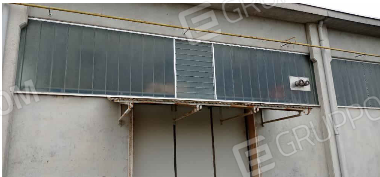
25-Vista esterna lato est pensilina
