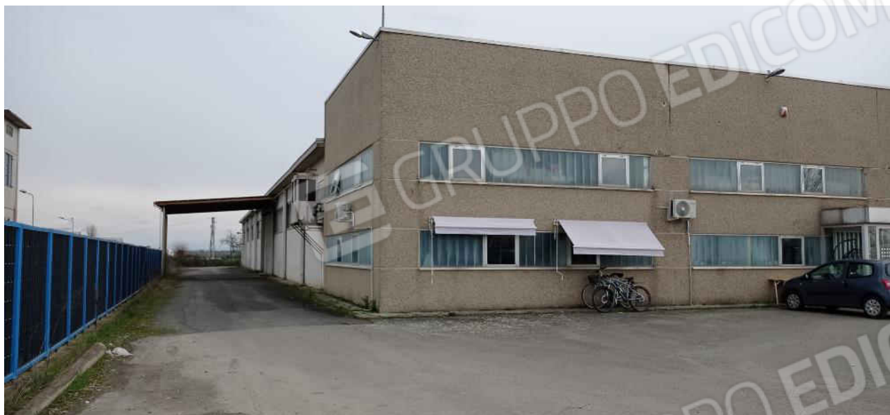
35-Vista esterna lato nord
