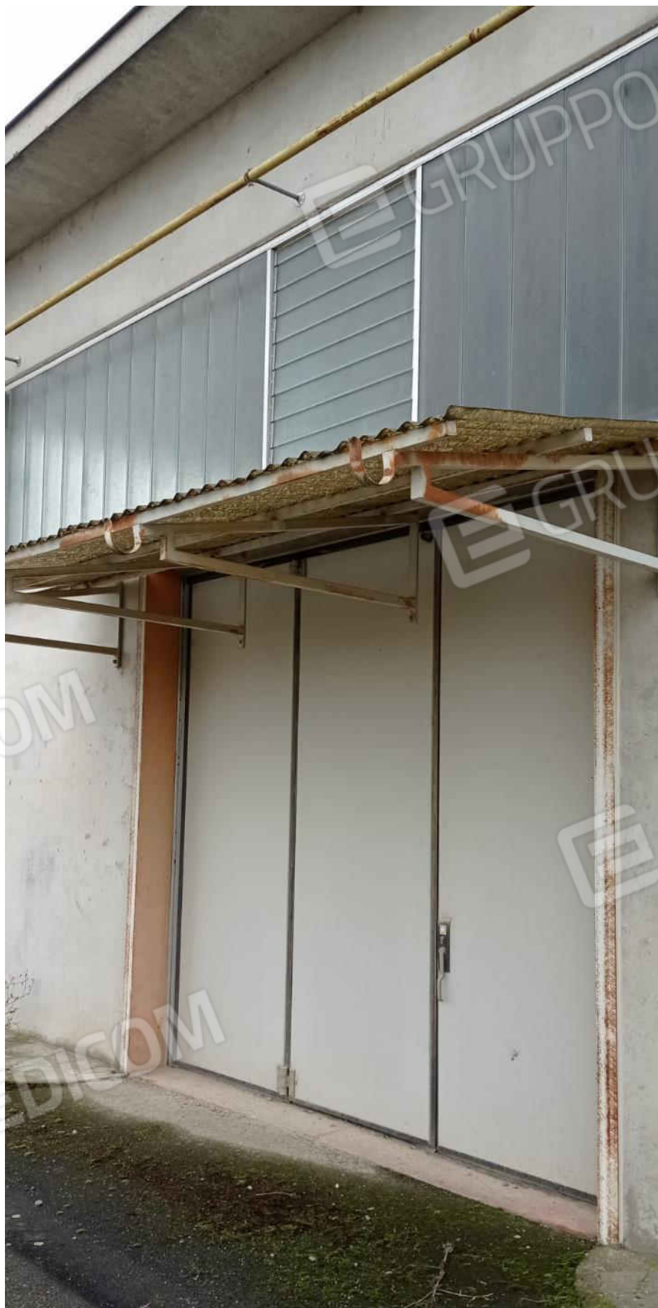
19- Vista esterna pensilina capannone lato est
