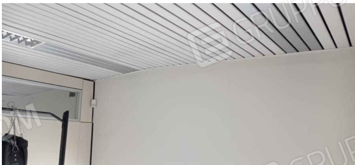
59-dettaglio controsoffitto piano primo
