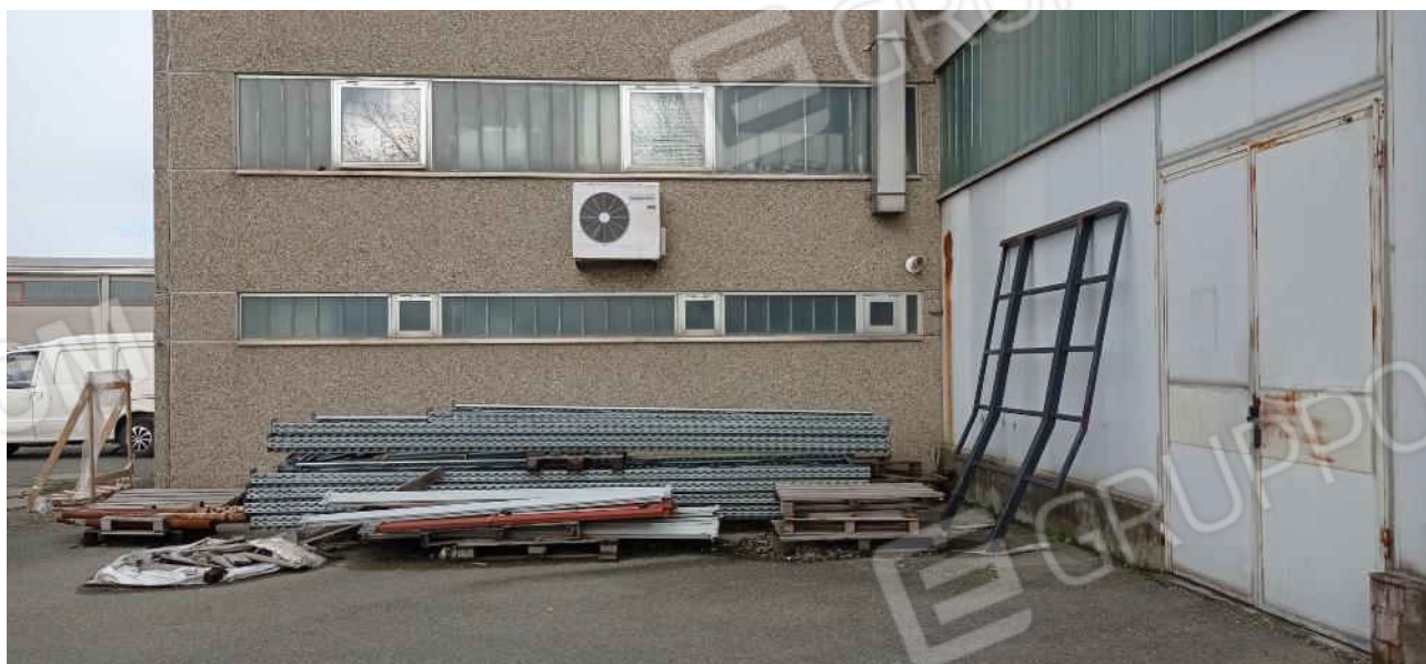
8- Vista esterna capannone
