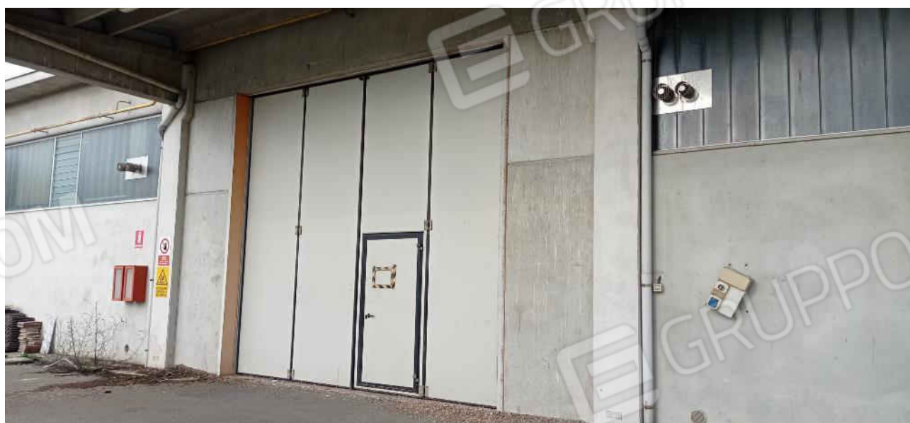
4- Vista pensilina capannone
