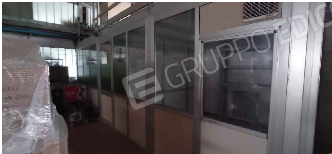
68-box uffici piano terreno
