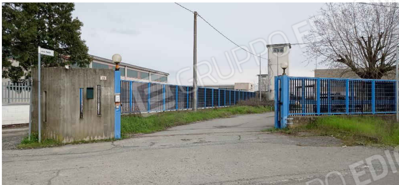
37-Vista esterna lato nord
