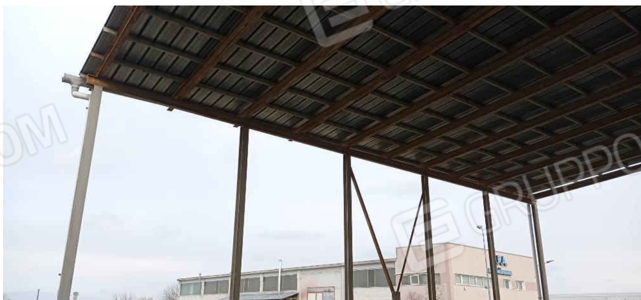
32-Vista esterna lato est
