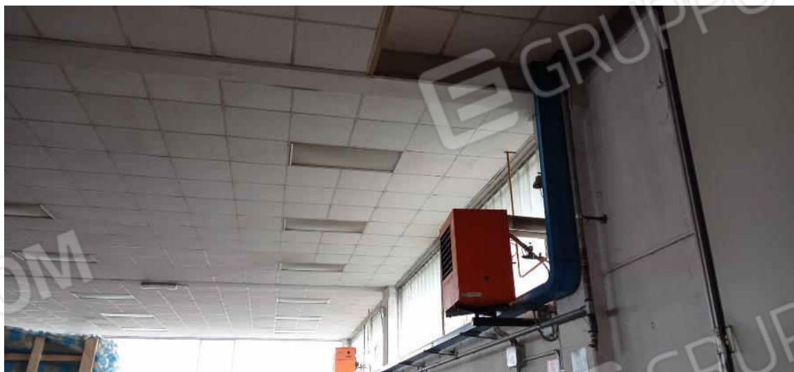
72-controsoffitto capannone (porzione verso terreni)
