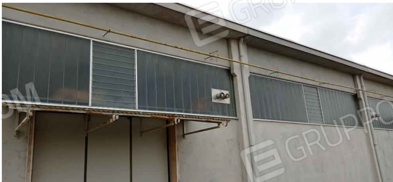
16- Vista esterna pensilina capannone lato est
