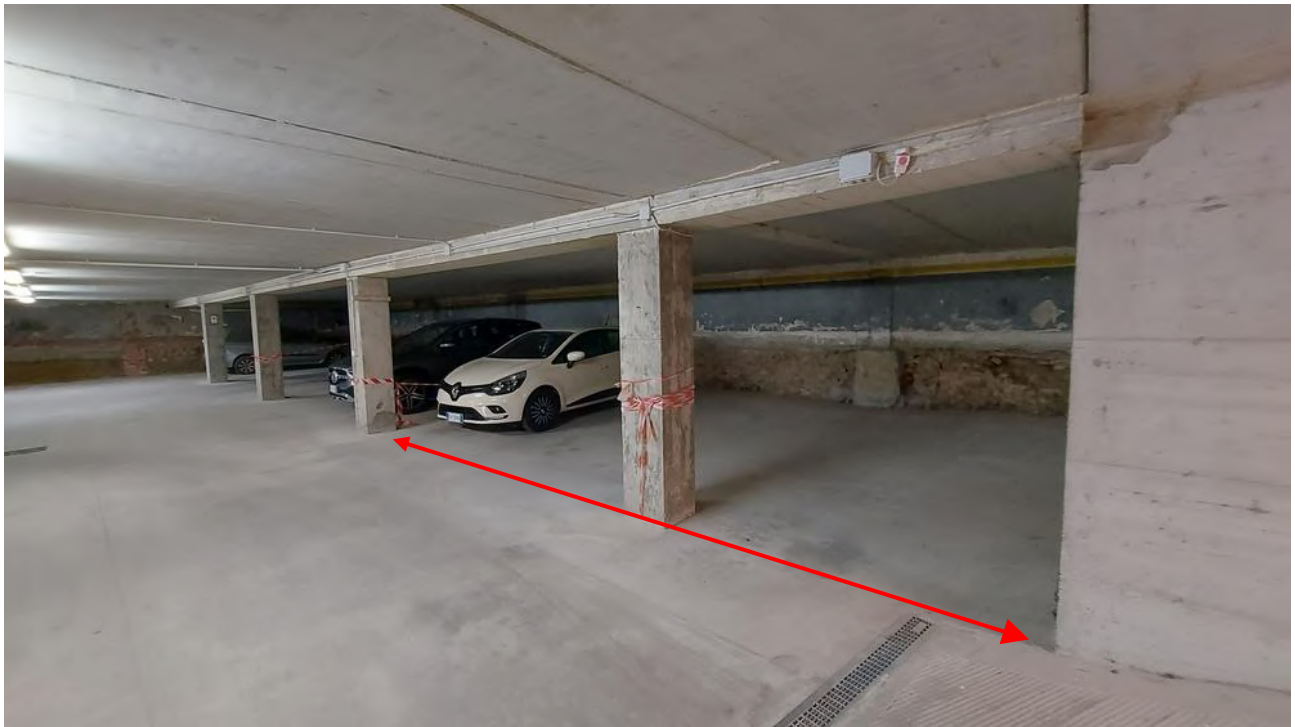
Foto 24 – Vista dal corridoio di manovra comune
