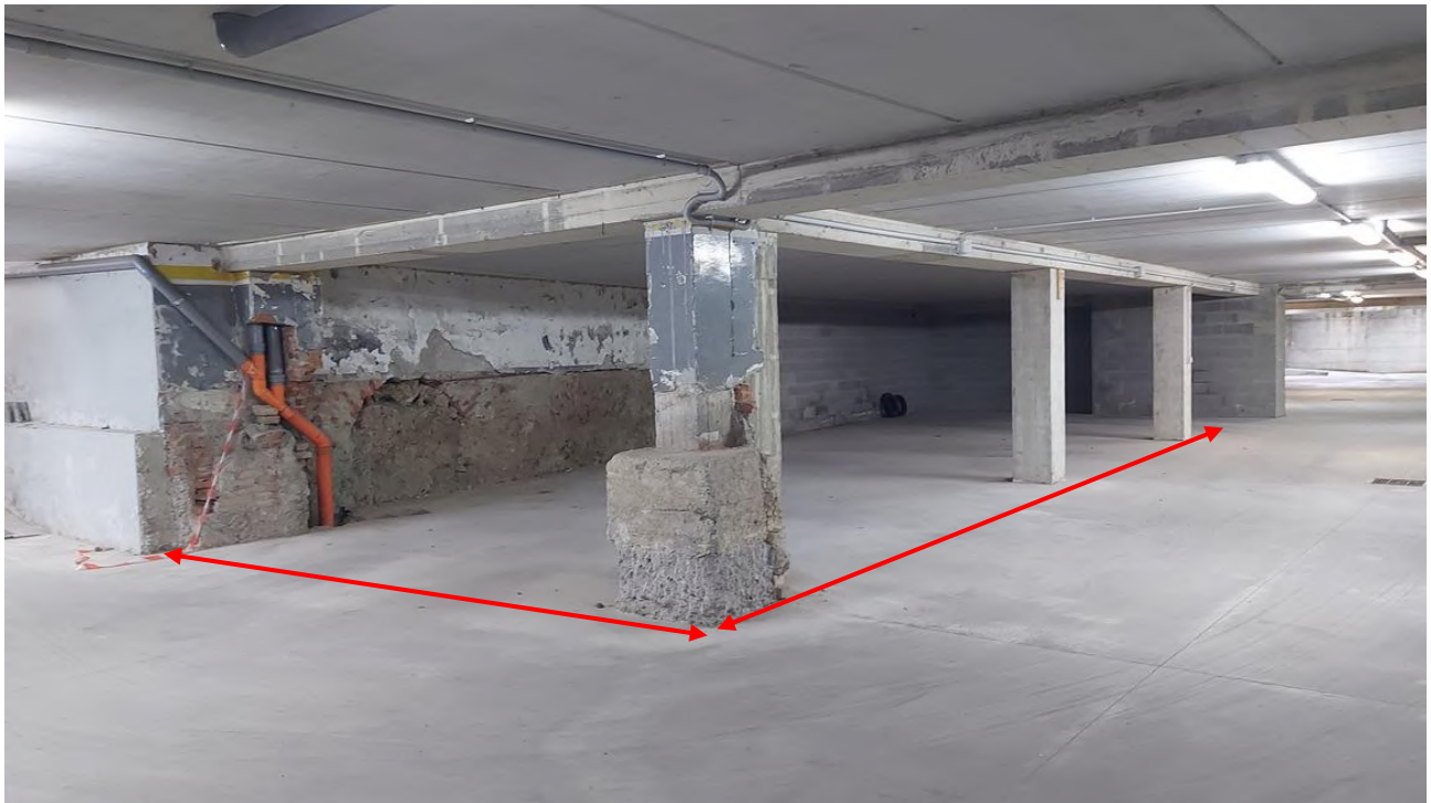
Foto 26 – Vista dal corridoio di manovra comune
