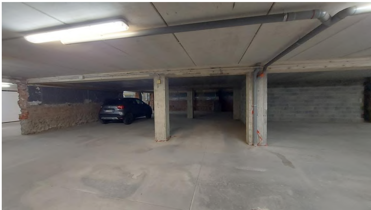
Foto 29 – Vista dal corridoio di manovra comune
