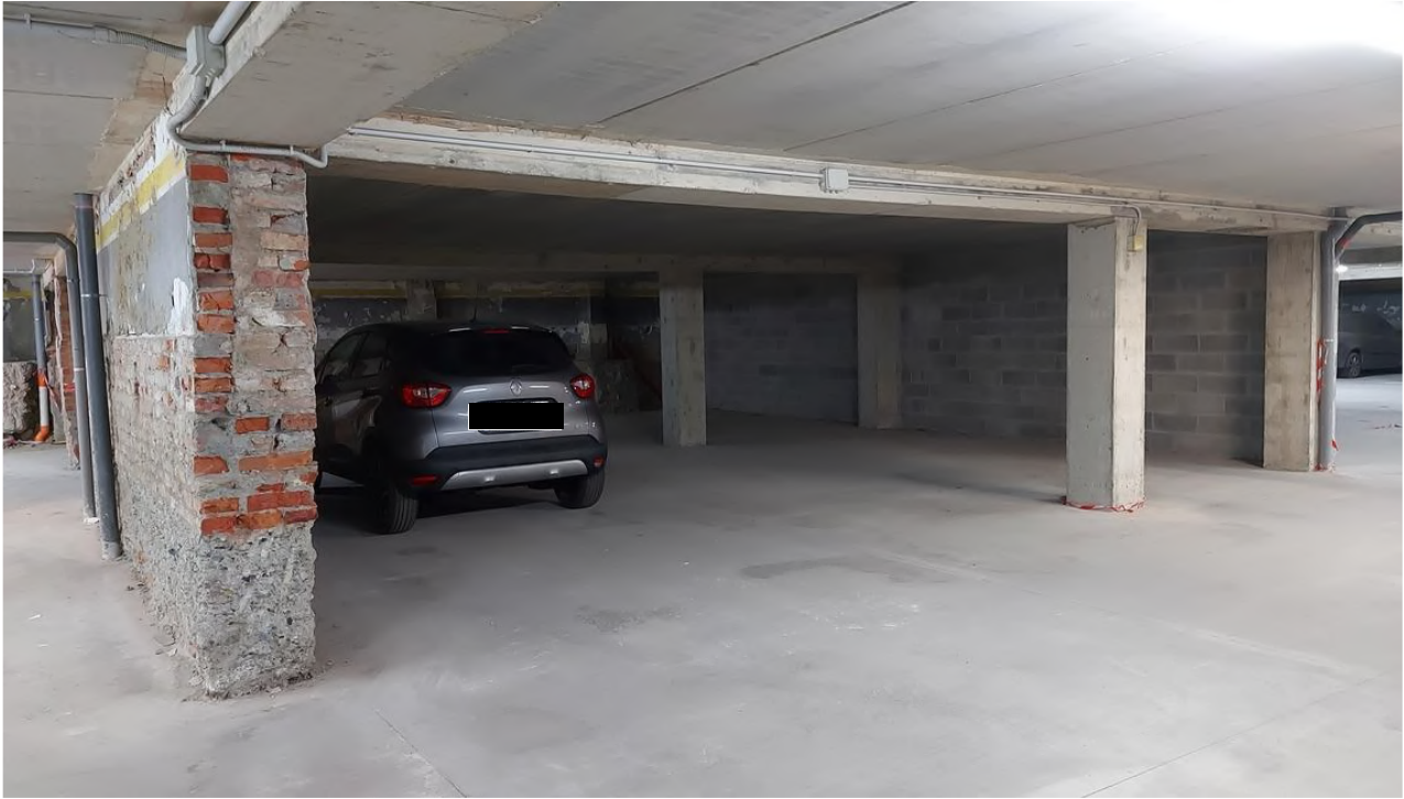
Foto 30 – Vista dal corridoio di manovra comune
