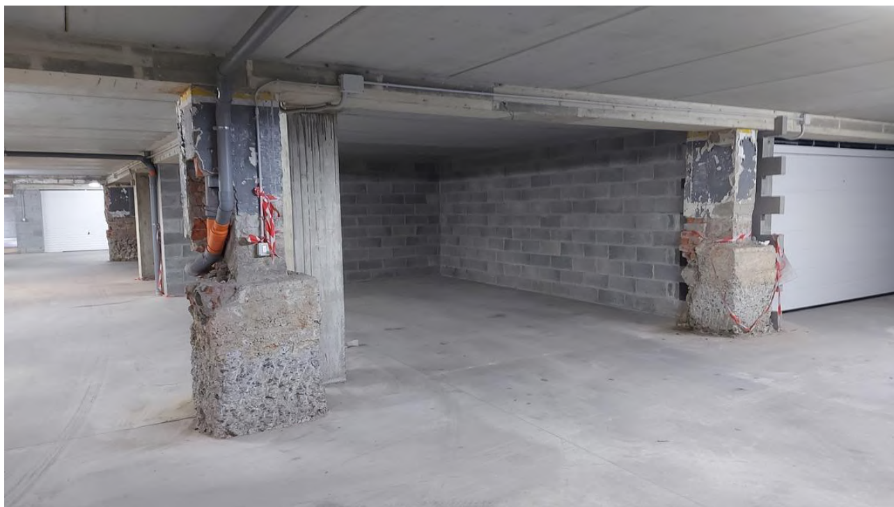
Foto 28 – Vista dal corridoio di manovra comune
