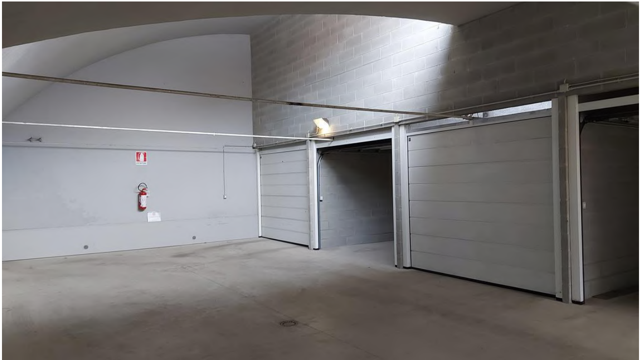
Foto 3 – Vista dal corridoio di manovra comune
