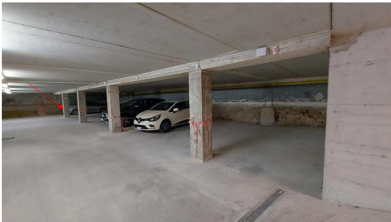
Foto 22 – Vista dal corridoio di manovra comune
