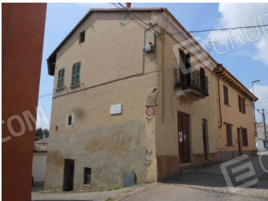
Foto 36 Prospetto Sud Lotto 2
