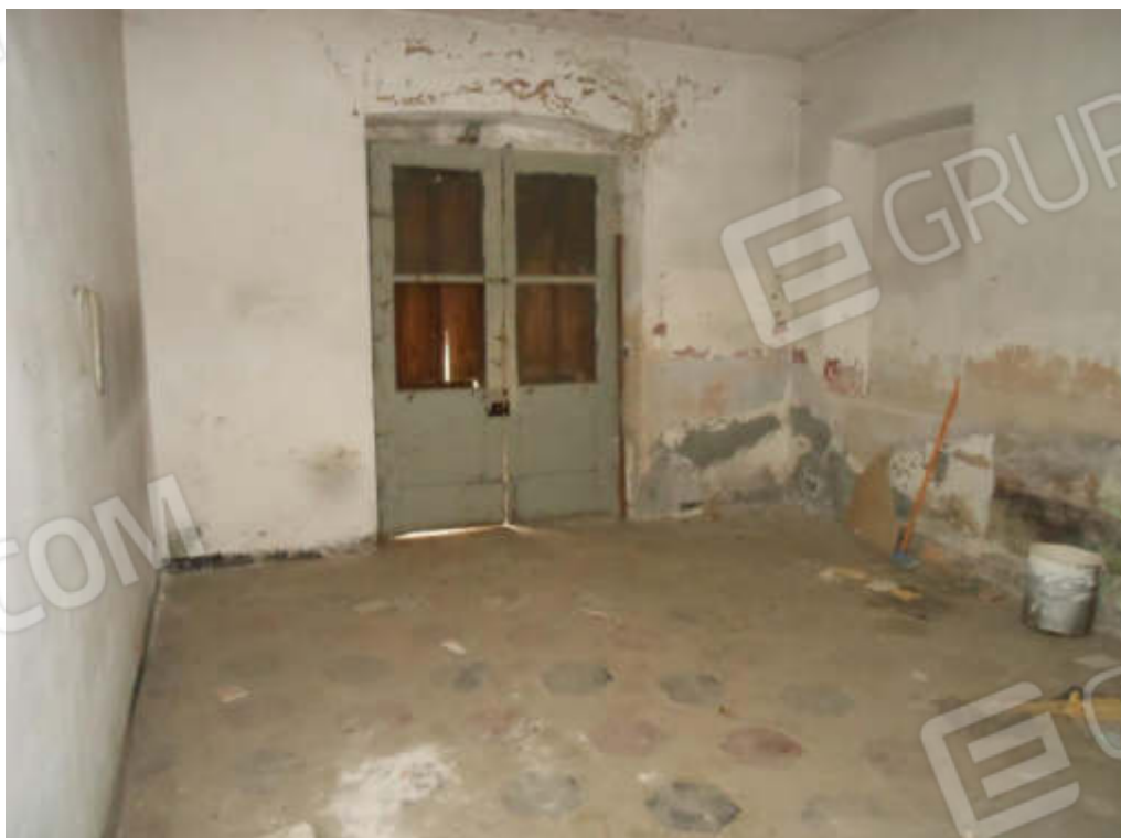
Foto 40 Camera piano terra Lotto 2
