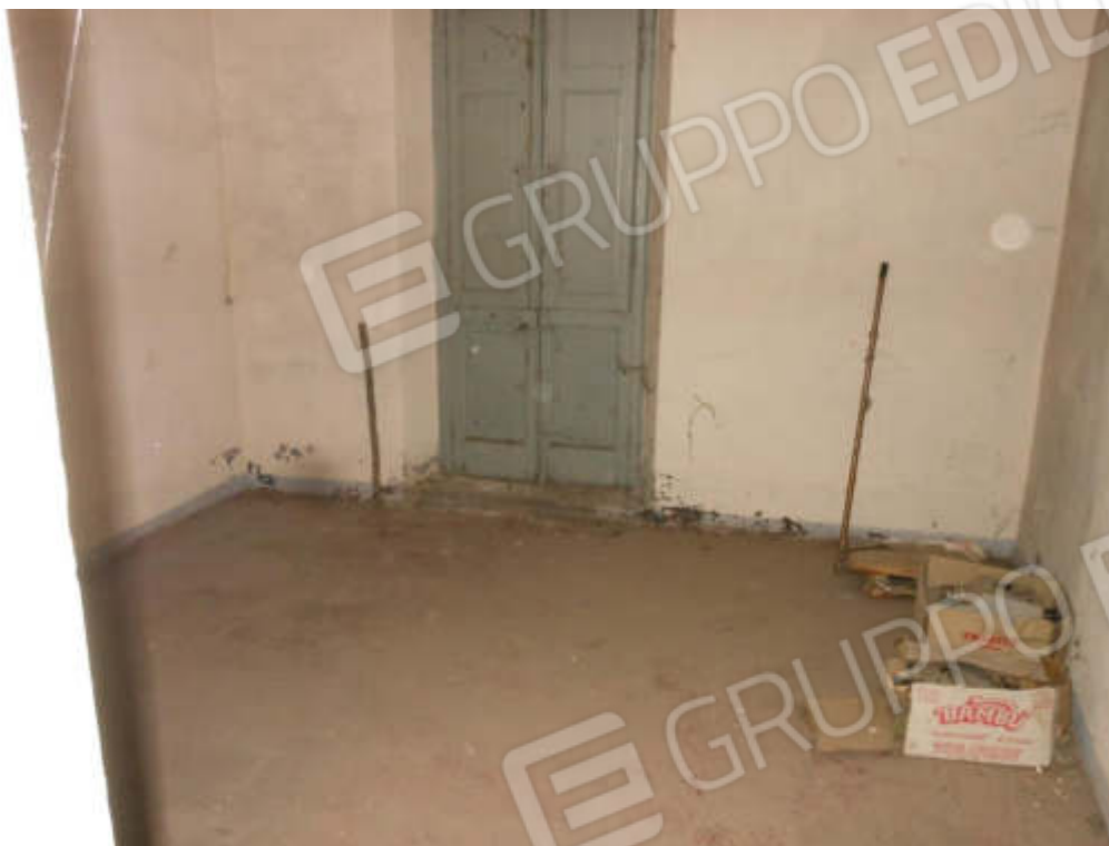
Foto 45 Camera piano primo Lotto 2
