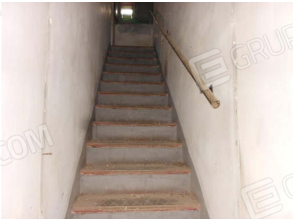
Foto 42 Scala accesso piano primo Lotto 2
