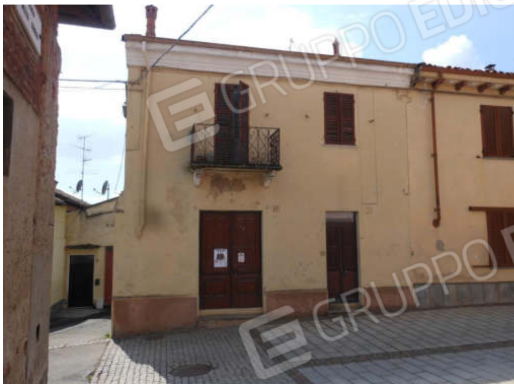
Foto 35 Prospetto su Via Italia Lotto 2
