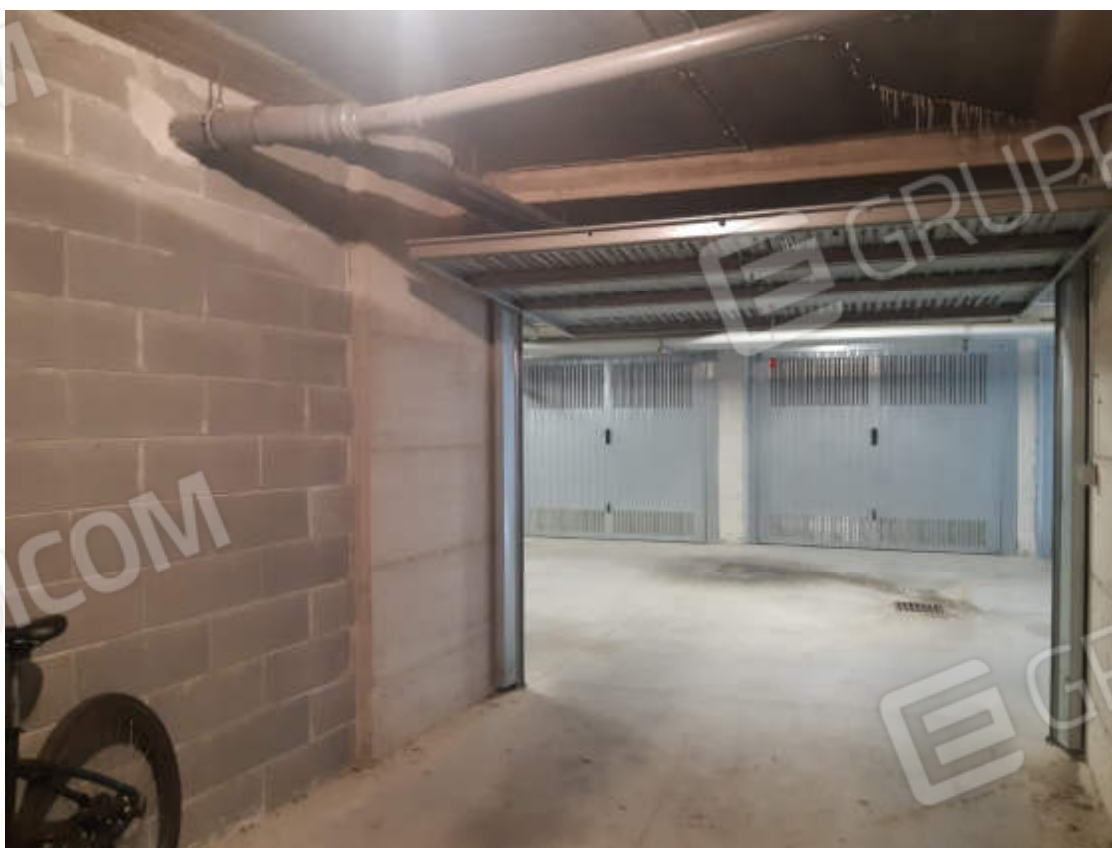
Vista interna della U.I.U. oggetto di valutazione
