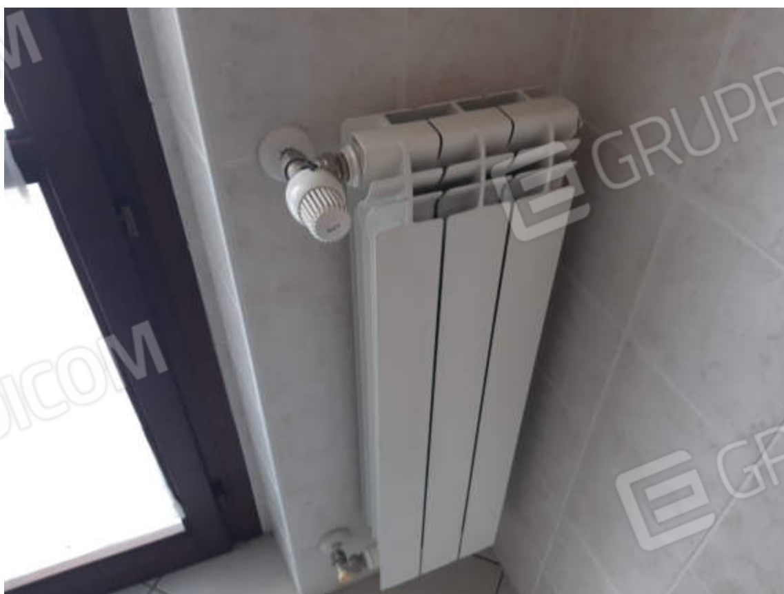
Vista particolare collettore impianto riscaldamento e tipologia termo valvole
