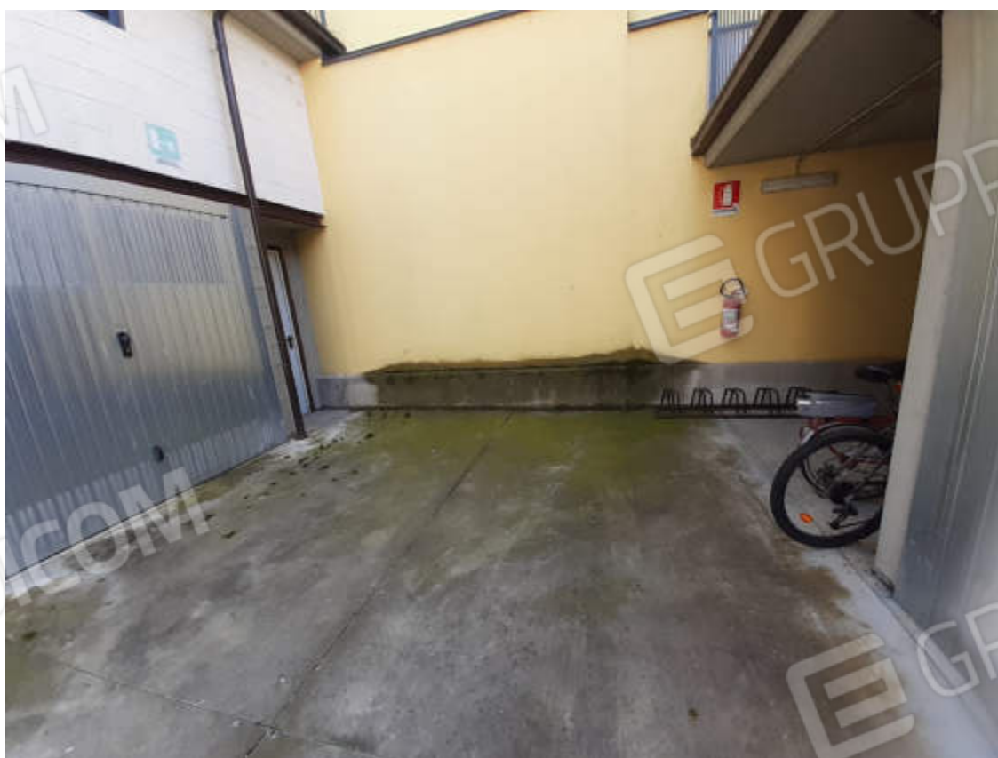
Vista da corsia comune di accesso della localizzazione del posto moto scoperto oggetto di valutazione
