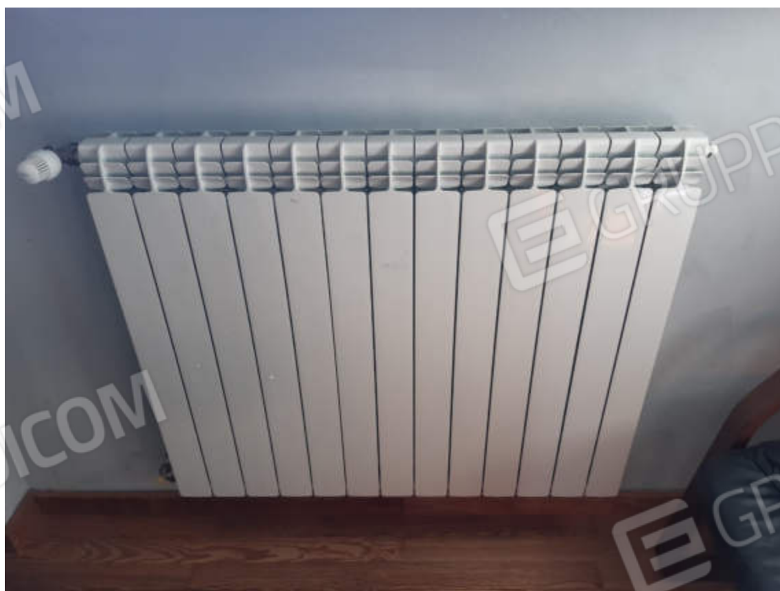
Vista particolare collettore impianto riscaldamento Tipologia batterie radianti a servizio dei locali di abitazione
