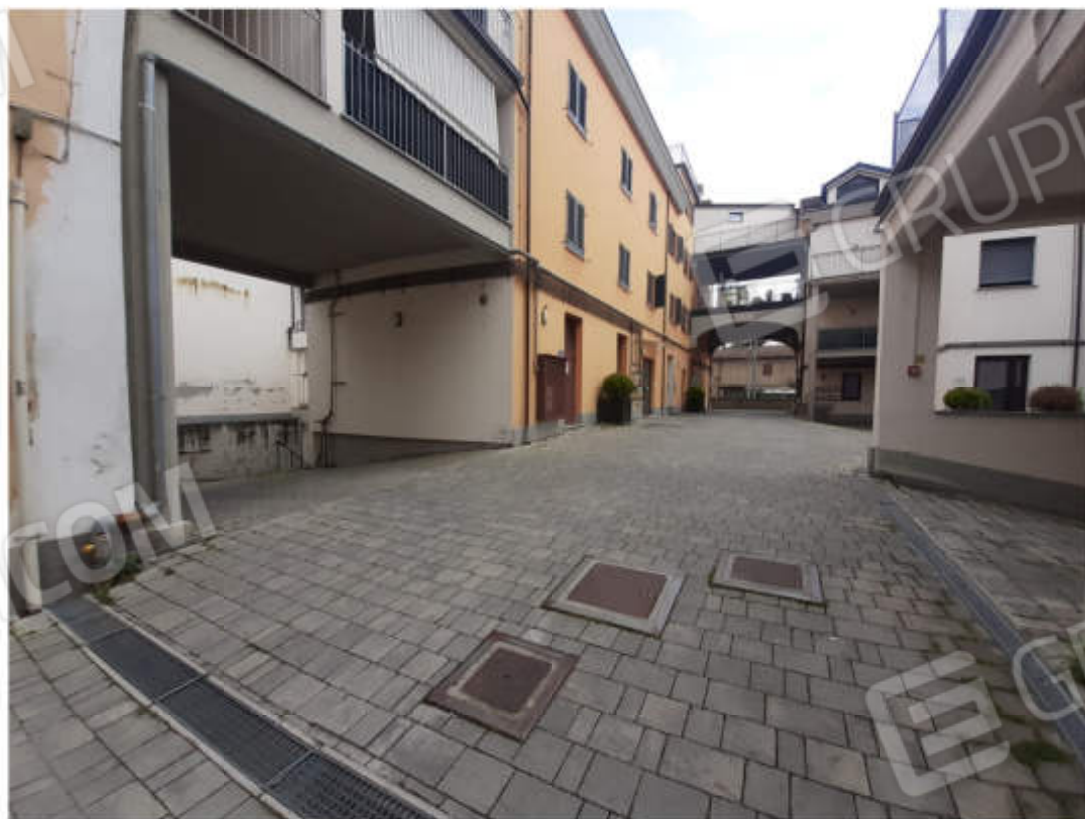
Vista del cortile interno comune alle U.I.U.
