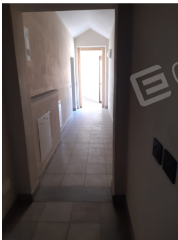
Vista corridoio comune in piano terzo di accesso alla U.I.U
