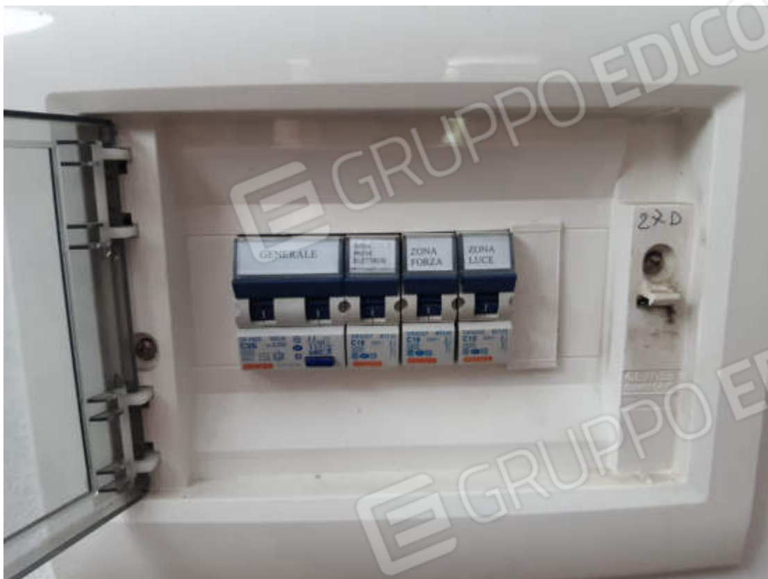
Vista particolare quadretto di utenza impianto elettrico
