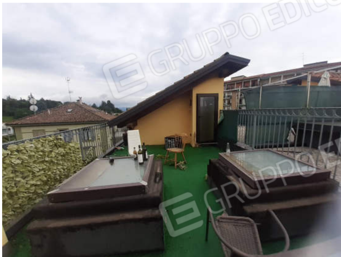
Vista balcone pertinenziale in piano sottotetto e scala di accesso al terrazzo in piano copertura
