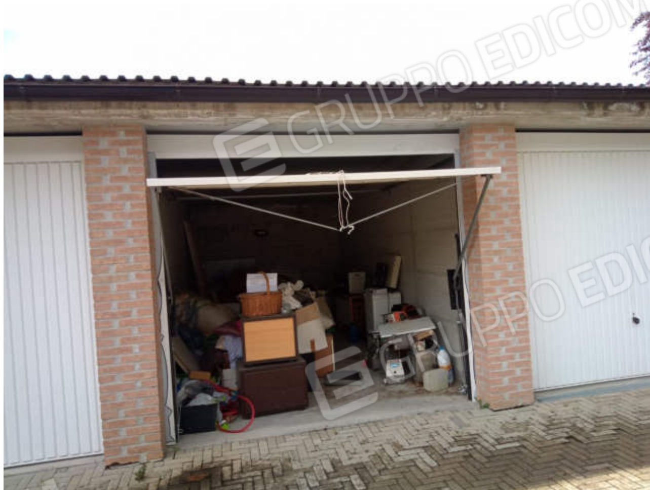
Vista particolare delle rifiniture e caratteristiche costruttive dell'U.I.U. destinata a box contenente materiali e merci ( basculante da riparare )
