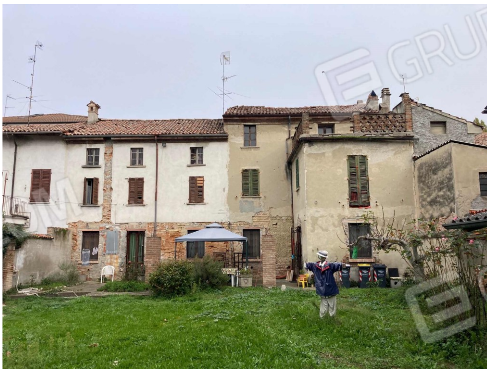
Foto 2 – Prospetto abitazione dal cortile
